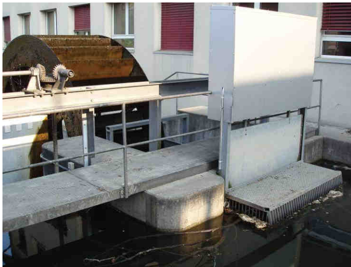
Fig. 20: Feinrechen und Einlaufschütze
