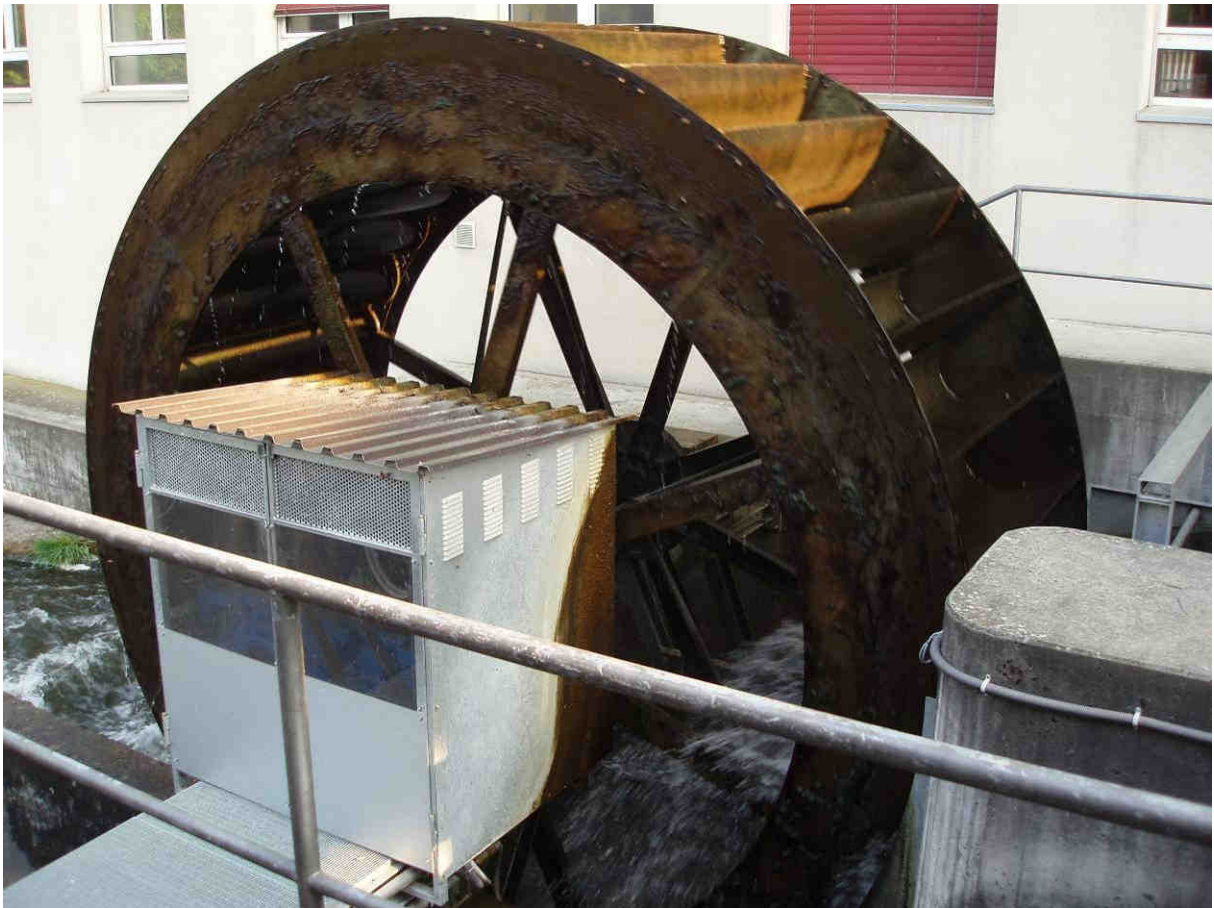
Fig. 18: Wasserrad Herzogenmühle in Wallisellen
