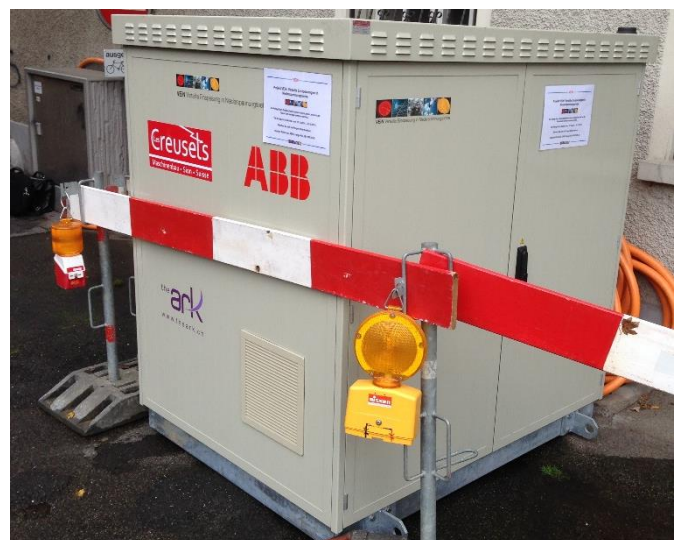
Abbildung 6: Mobiler FU platziert bei Kabelkabine (links)
