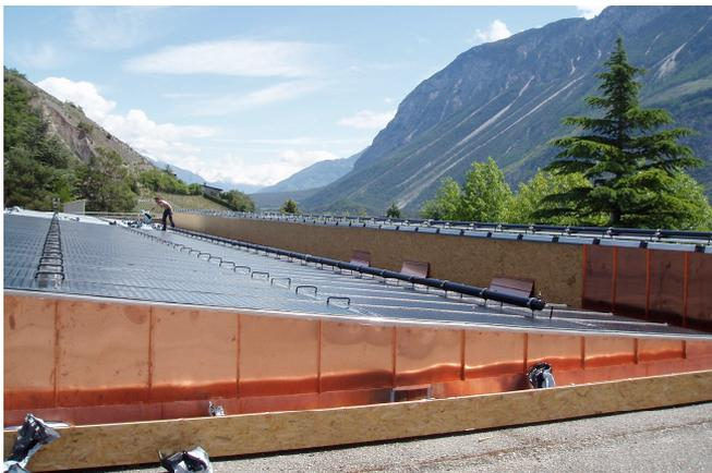
TOITURE SOLAIRE AS d'une surface totale de 600 m<sup>2</sup>, dont 591 actifs, est montée en deux champs, sur une structure en bois lui donnant une pente de 5°, les eaux d'écoulement étant recueillies dans des chéneaux en cuivre. Les ferblanteries latérales, sur les parties verticales de la structure en bois, sont également réalisées en cuivre. Les parties inférieures de la TOITURE SOLAIRE AS qui sont fréquemment dans l'ombre portée de l'acrotère ou du champ de capteurs voisin sont inactives.
