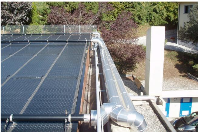
double conduite isolée (3) entre la toiture et le local technique, une pompe de circulation (4), un compteur de chaleur (5), un système d'expansion (6), et deux échangeurs à plaques (7 et 8) de 420 kW ( $\Delta T=5K$ ) avec une vanne de passage (9 et 10) sur chacun d'eux.
