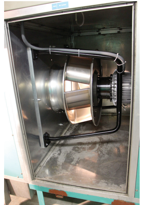
Alt und neu im Vergleich: Links ein alter Ventilator mit Spiralgehäuse, Keilriemenantrieb und Frequenzumformer; recht ein moderner EC-Radialventilator. Fotos: ZIG/HSLU
