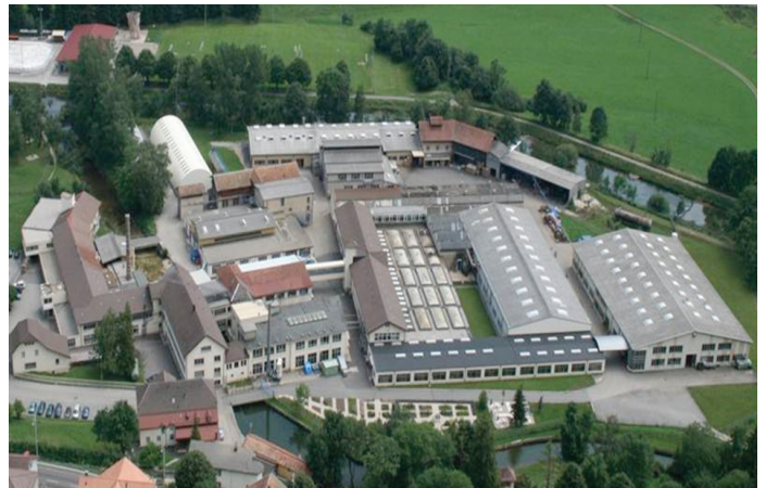
Dans l'installation du site des Usines Métallurgiques de Vallorbe SA à Vallorbe, le système de gestion de l'énergie SEMS de Stignergy a été testé dans le cadre d'un projet pilote de démonstration. Photo : UMV
