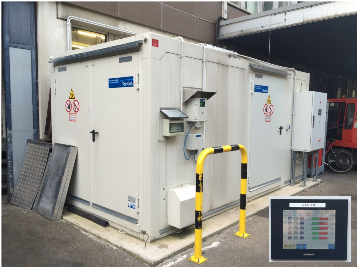
Abbildung 6. Füllanlage im Hof der Elvetino. Die Füllstationen und Gasflaschenbündel befinden sich im inneren des Containers. Die LED-Anzeige gibt die Informationen zum Füllprozess weiter
