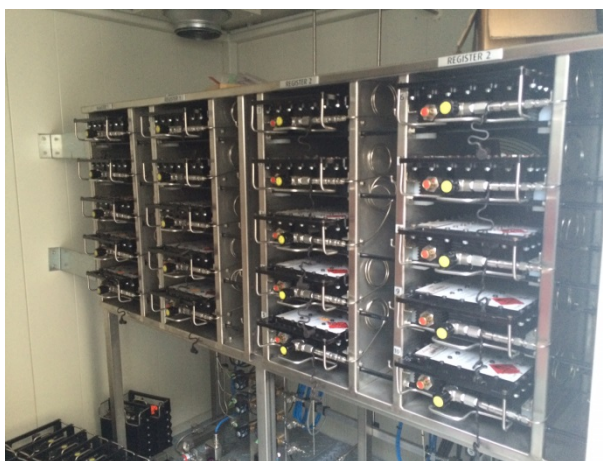
Abbildung 7. Füllstationen mit 2 Register à 10 Positionen. Die LED-Anzeige aussen am Container gibt die Information zum Füllstand bzw. Füllprozess weiter.
