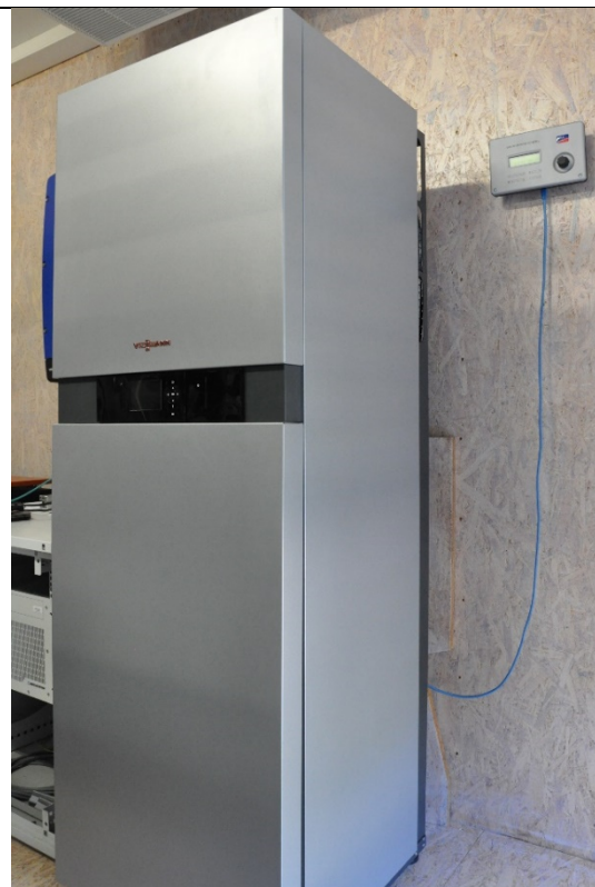
Abb. 30: Vitocharge Batteriestation mit Stromspeicher und Remote Control Einheit
