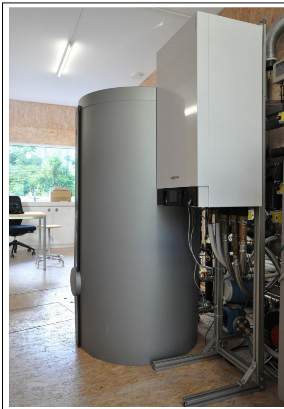
Abb. 24: Wärmepumpen-Inneneinheit mit Warmwasserspeicher
