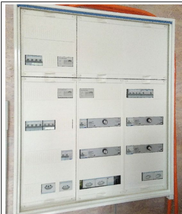
Abb. 27: Hausverteiler mit Energy-Metern, SPS-Steuerung, Messwandlern und Haushaltsstrom-Emulatoren
