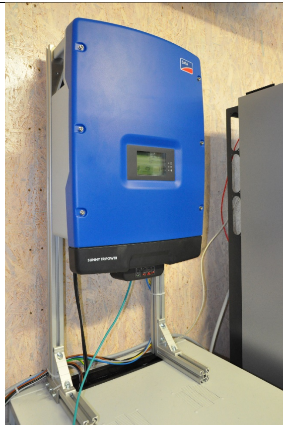
Abb. 29: PV-Wechselrichter
