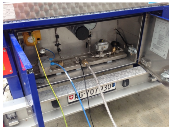
Abb. 3: Abfüllanlage (links) mit dem technischen Hochdruckspeicher in Rot. Rechts sind die Anschlüsse an den Trailer ersichtlich (Gasleitung, Druckluft für die Betätigung des Hauptventils, Datenleitung und ein Erdungskabel)
