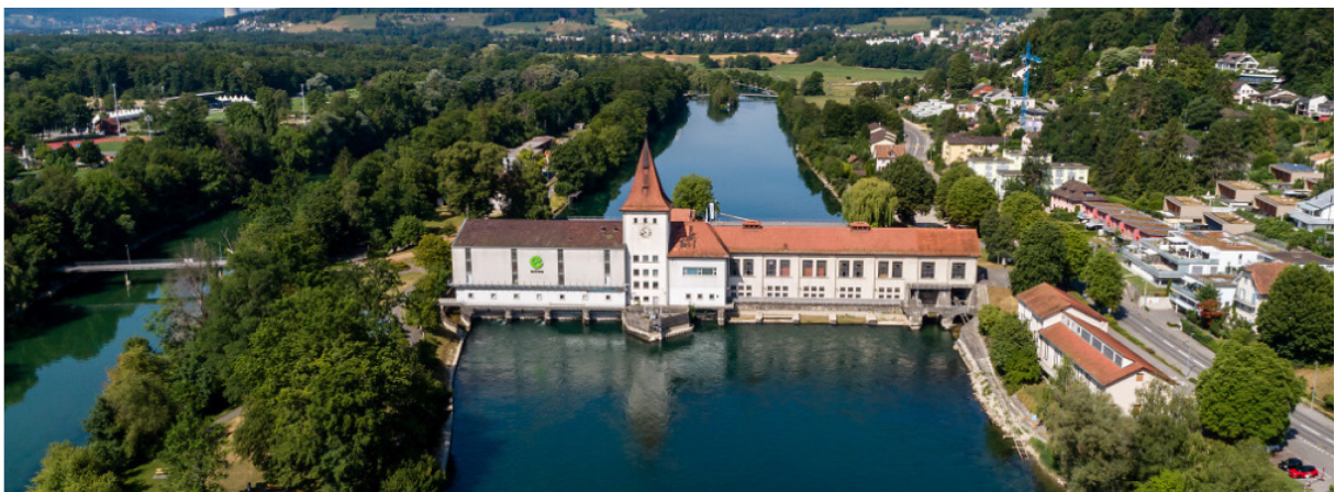
Abb. 1: Laufwasserkraftwerke der Eniwa AG an der Aare in Aarau mit 16 MW Nennleistung und durchschnittlicher Stromproduktion von 101 GWh/a.
