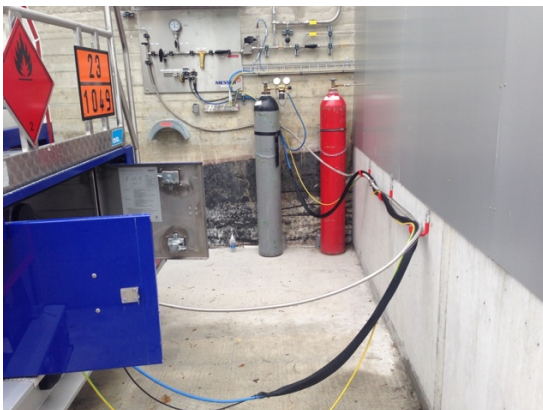
Abb. 3: Abfüllanlage (links) mit dem technischen Hochdruckspeicher in Rot. Rechts sind die Anschlüsse an den Trailer ersichtlich (Gasleitung, Druckluft für die Betätigung des Hauptventils, Datenleitung und ein Erdungskabel)
