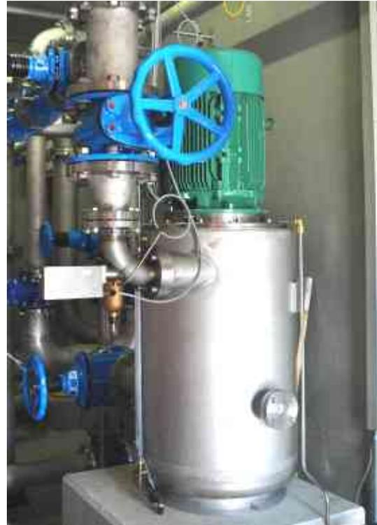
Fig. 6: Gegendruckturbine in Gordola
