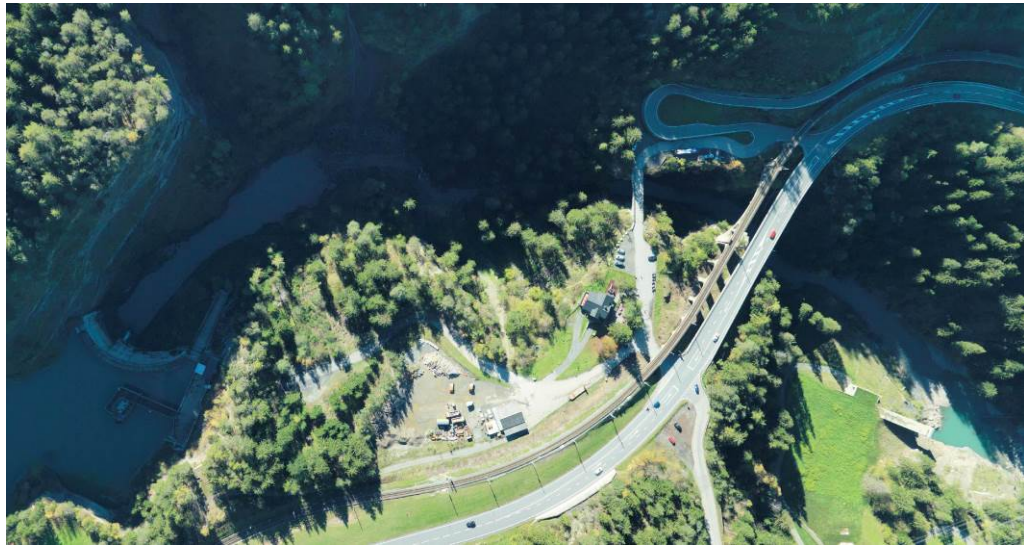
Abbildung 8: Luftaufnahme während der ersten LiDAR-Vermessung (18. Oktober 2014) von der Solis-Staumauer (links) und dem Auslaufbauwerk des Solis-SBT (rechts)
