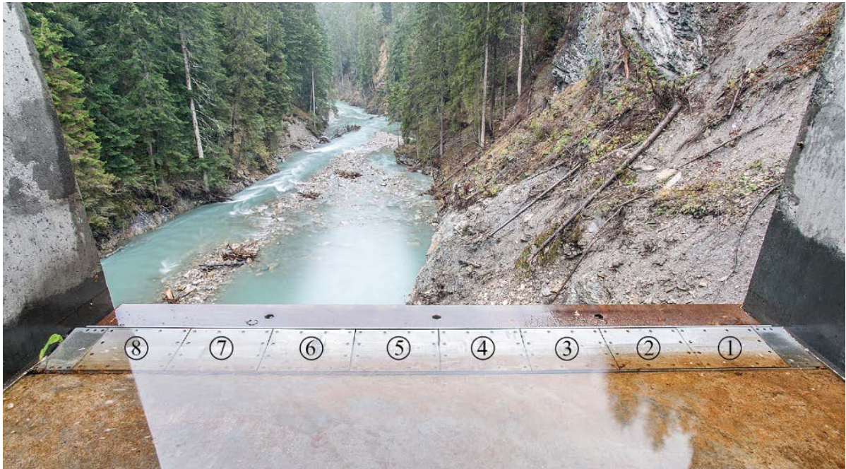
Abbildung 5: Geophonanlage am Auslauf des SBT Solis, bestehend aus acht Messeinheiten (Blick in Fließrichtung)
