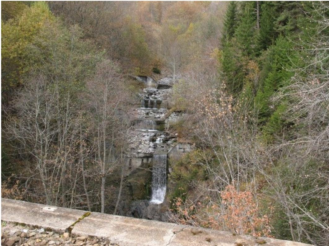
**Bild 5:** Farbtobel mit zahlreichen Sohlschwellen (Blick bachaufwärts ab Brücke RhB)
