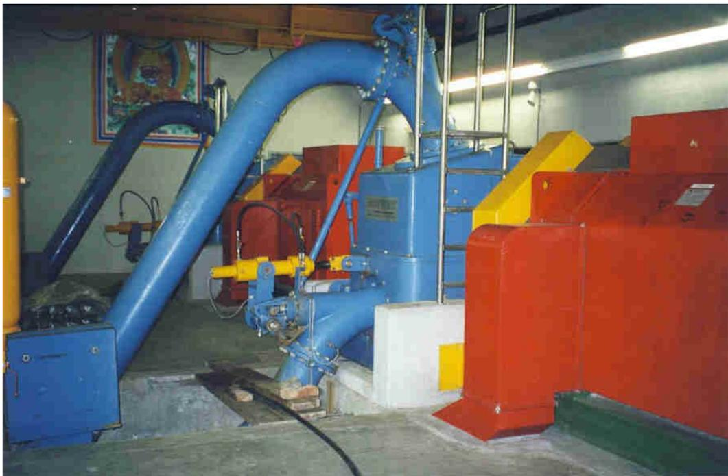
**Bild 16:** Beispiel einer Kleinwasserkraftanlage mit 2-düsig horizontalachsigen Peltonmaschinen mit Synchrongeneratoren
