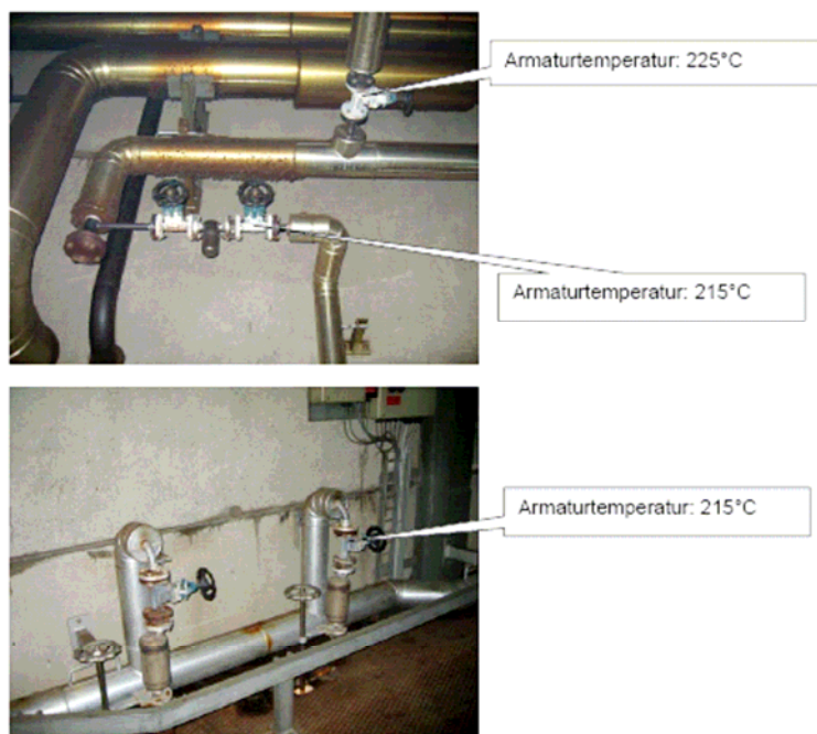
Abbildung 10: Unisolierte Armaturen auf der rechten Seite des Trockners
