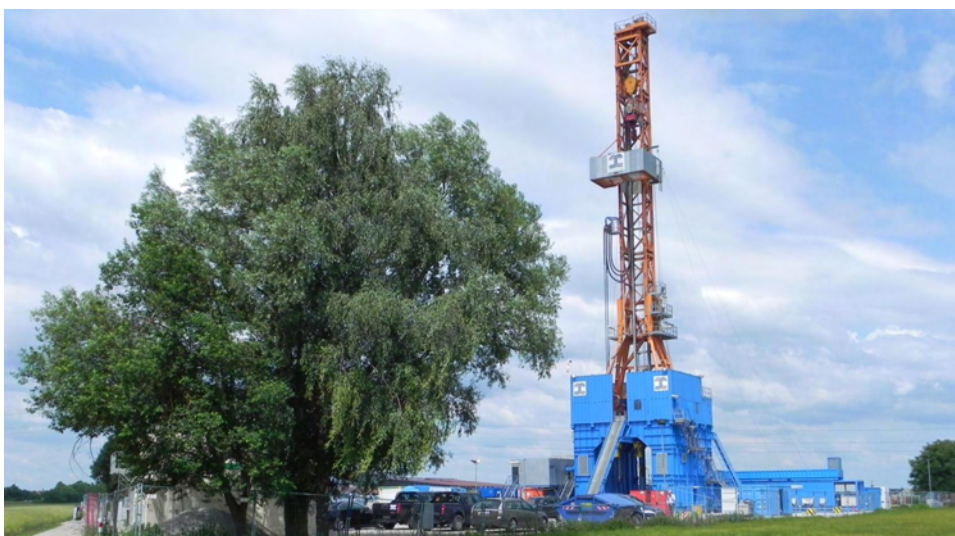
Installation de forage à Taufkirchen (bassin munichoïse) © Axpo
