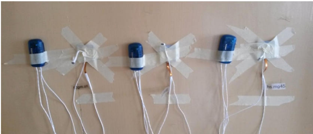
Abbildung 4: Installation 3 Messsensoren innen (Objekt 7-VH-01)
