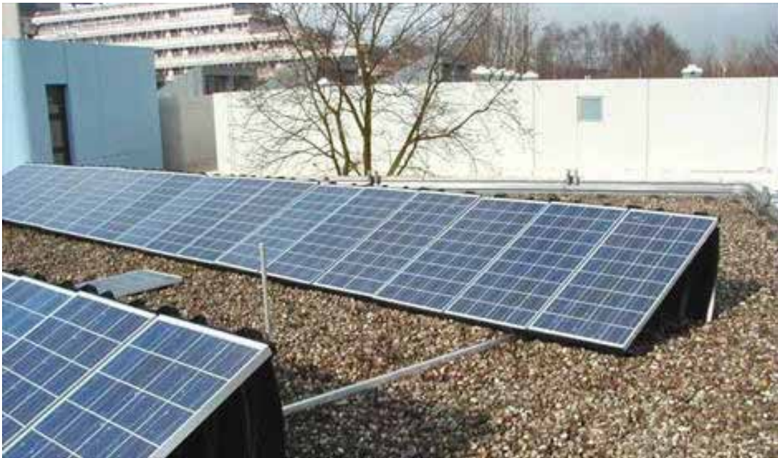
PV array on a flat roof, in Bochum (Deutschland), 20 kW, 1999
