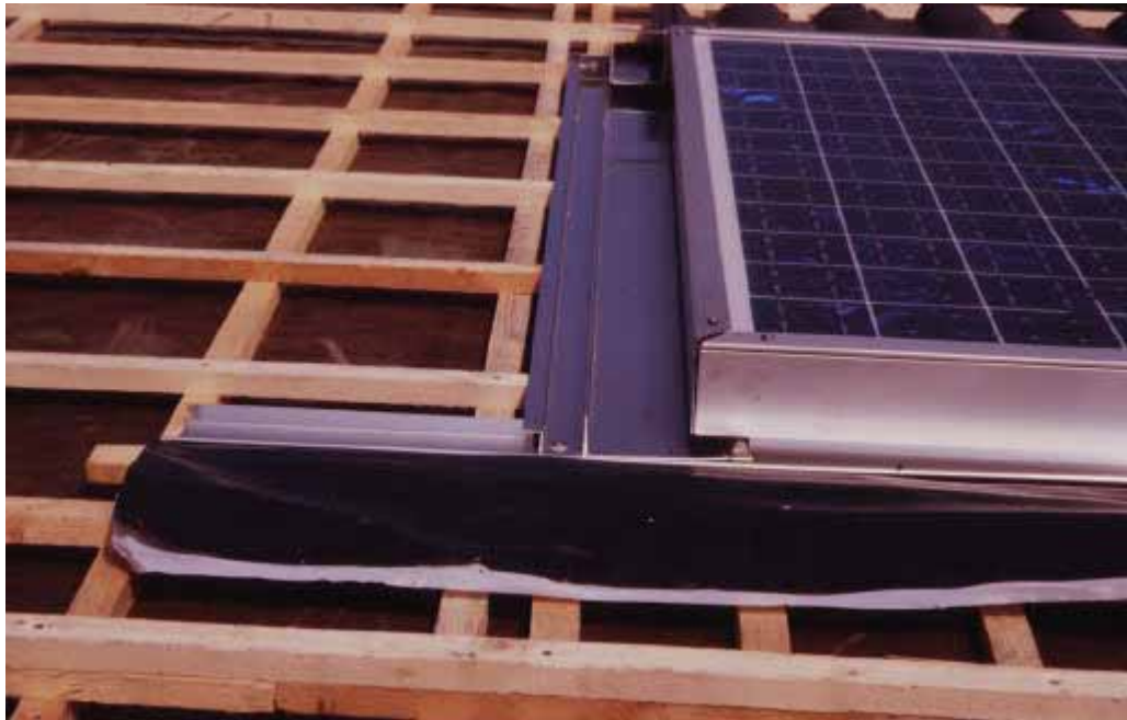
Figure70 : l'étanchéité est résolue de manière similaire aux « Velux ».
