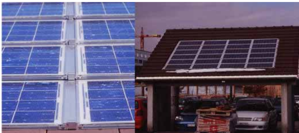
Figure 66 : Toiture inclinée avec intégration des éléments SOLRIF
