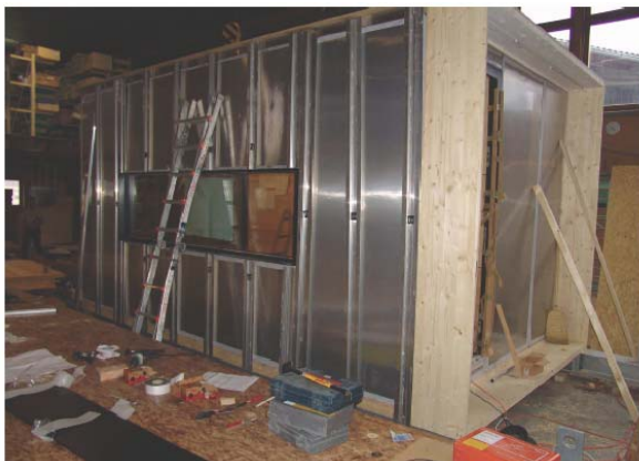
Fig. 3: Links: Der Pavillon im Bau, gut zu sehen sind die Alu-beplankten QASA-Elemente. Rechts: Fertiger Pavillon.
