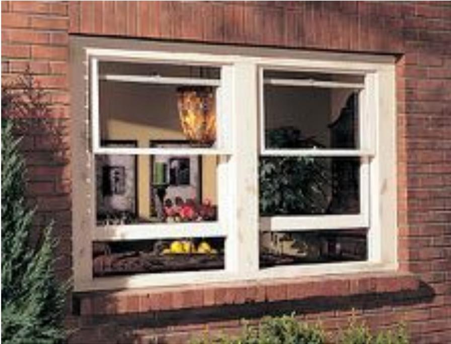
**Abbildung A3:** Beispiel für ein *double hung window*, wie es in Nordamerika und Grossbritannien eingebaut wird
