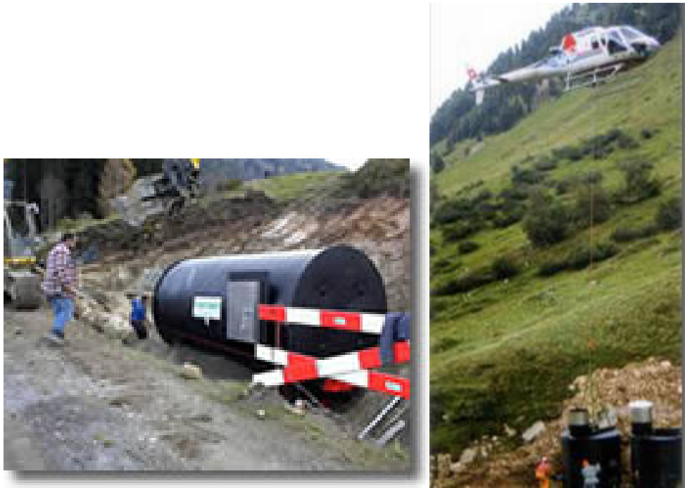
Abbildung 6: Links; Beispiel für eine vorfabrizierte Brunnenstube in liegender Ausführung. Links; Versetzen und Transport mit Helikopter. (Quelle der Fotos; Fa. etertub)
