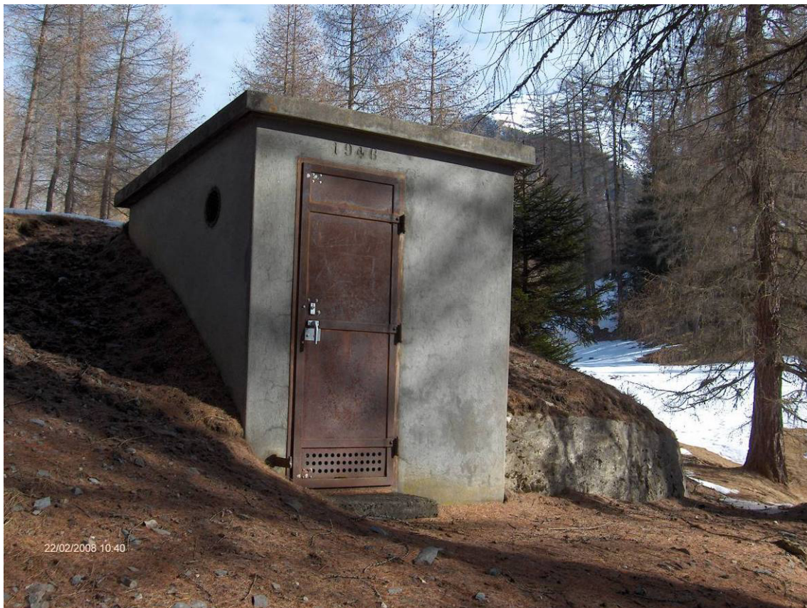
Abbildung 10: Bestehendes Reservoir Trans
