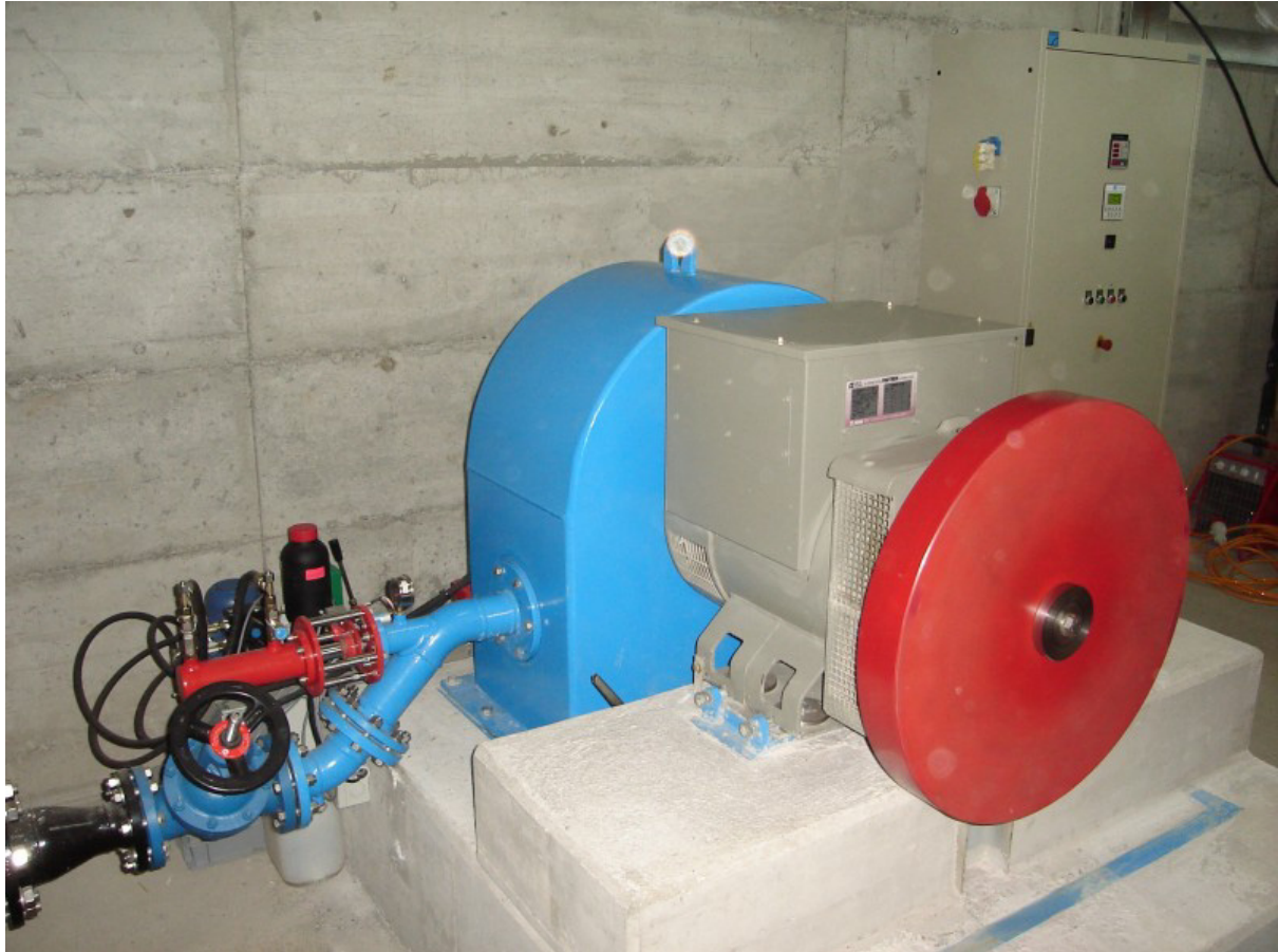
Abbildung 10: Beispiel für kleine Pelton turbine (horizontalachsig) mit Generator für Trinkwasserkraftwerk
