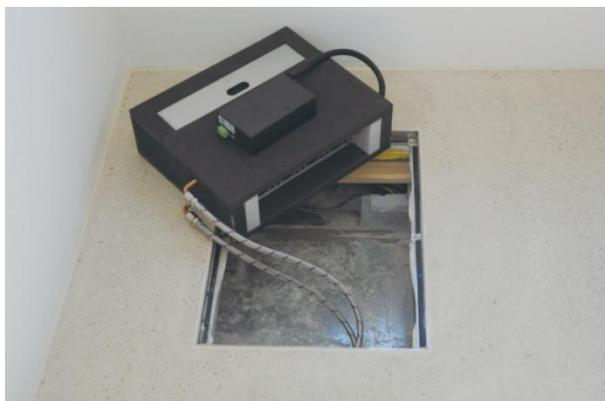
Abb. 6: Einbau der Airbox in die Installationsbox
