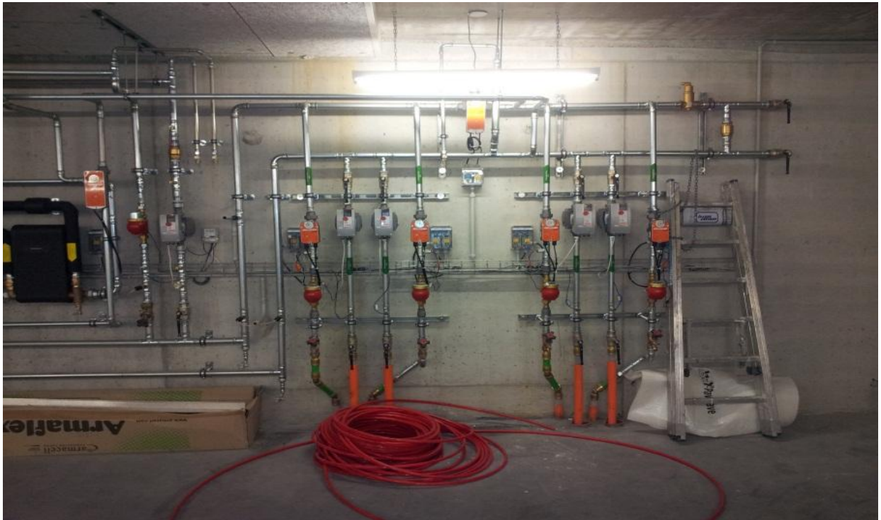
Fig. 2: Installation Erdsonden mit Durchflussmessern
