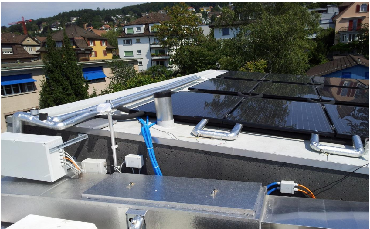
Fig. 1: Abluftkühler und Hybridkollektorfeld
