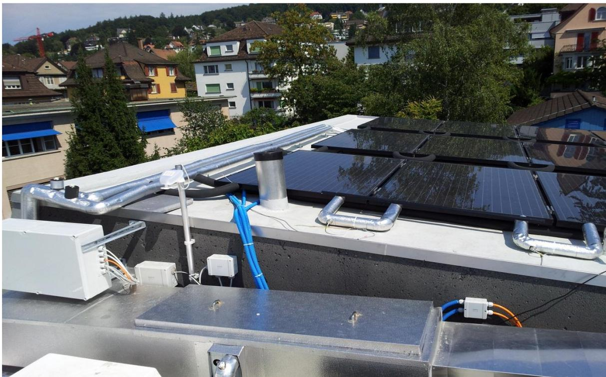
Fig. 1: Abluftkühler und Hybridkollektorfeld
