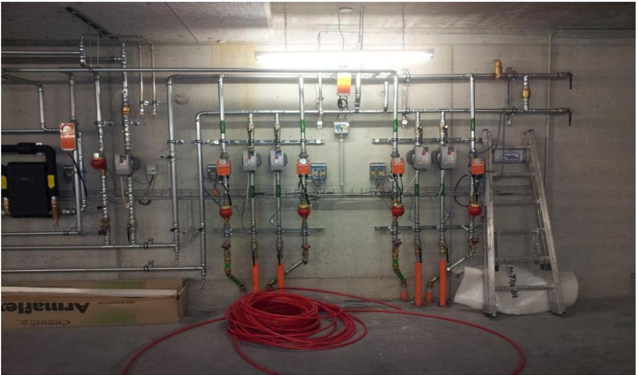
Fig. 2: Installation Erdsonden mit Durchflussmessern
