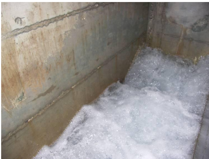
Schäumendes Wasser im Druckbrecherschacht (= ungenutzte Energie)
