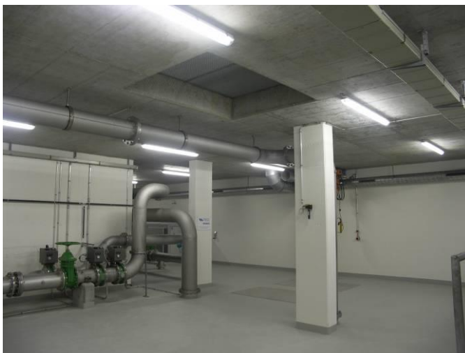
Bereits vorgesehene Öffnung in der Decke für den Maschinen-Transport
