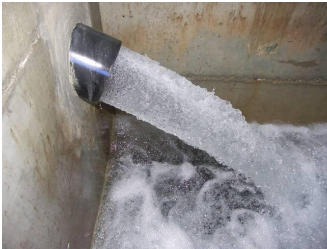
Zuleitung von Hundschopf-Bofel her in den Druckbrecherschacht vor dem Reservoir St. Niklausen
