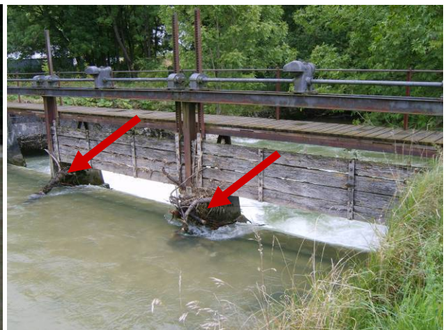
Solides accumulés contre les supports d'ancrage des batardeaux (constat du 04.09.2007)
