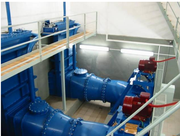
Exemple de 2 x groupe Semi-Kaplan type « S » avec vanne guillotine et génératrice montée à la verticale à l'aide d'un entraînement à courroie (HYDROHROM, Bechyně CZ)
