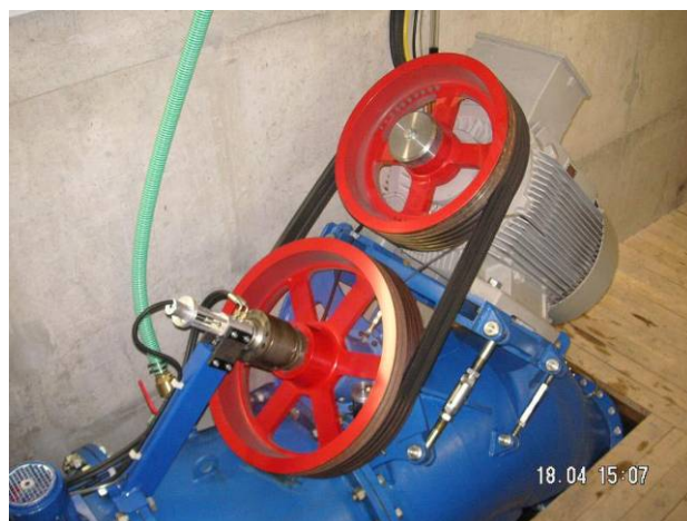
Entraînement avec courroies en V sur turbine de type « K » (HYDROHROM)
