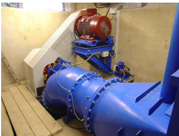
Exemple d'un groupe Semi-Kaplan avec génératrice montée sur le côté (HYDROHROM, Hazelbank IR)
