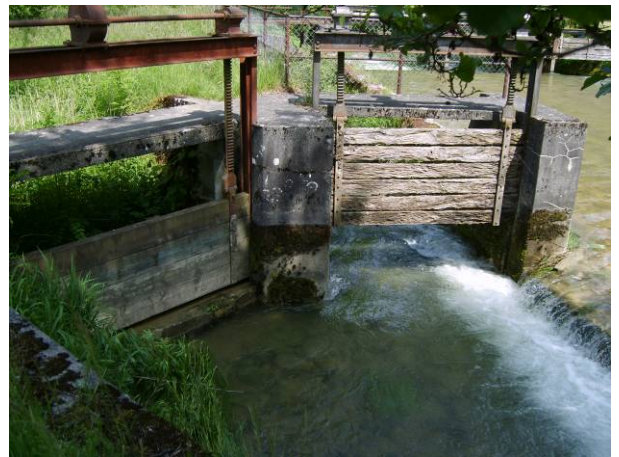
Ecluse (vanne batardeau) d'isolation du canal d'amenée de la scierie et écluse de purge du déversoir latéral
