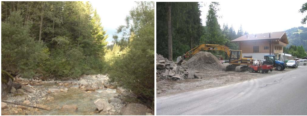
Abb. 2: Fassungsstandort unterhalb der Einmündung des Turnelsbachs (linkes Bild) und geplanter Zentralenstandort
