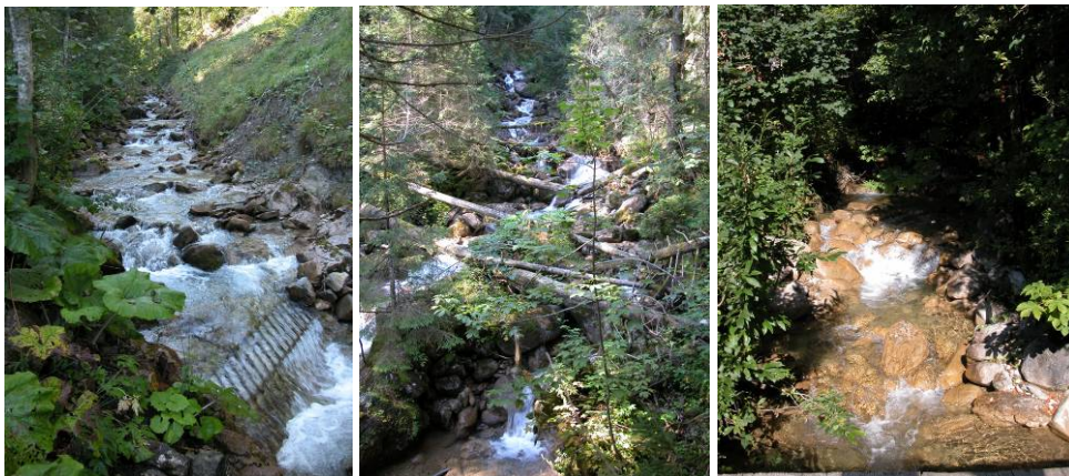
Abb. 4: Bestehende Wasserfassung des KW Chalbergarte (links), wenig einsehbare Steilstrecke oberhalb der bestehenden Zentrale des KW's (Mitte) und starke Verkalkung (rechts)
