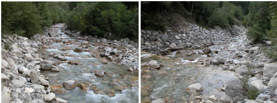
Abb. 4: Recht gut strukturiertes Bachbett ca. 100 unterhalb des vorgesehenen Fassungsstandortes (linkes Bild); Sicherung von Hangrissen mit Blöcken weiter unten
