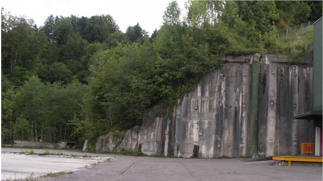
Ca. Standort künftige Zentrale (am linken Ende der Felswand). Die Druckleitung wird oberhalb der Felswand umgelenkt und entlang der oberen Felskante schräg nach unten zur Zentrale geführt.
