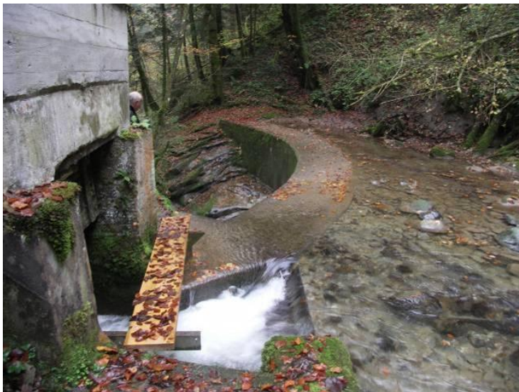
Fassung Ranzach unterhalb Lindenplatz, Sperre und Einlauf
