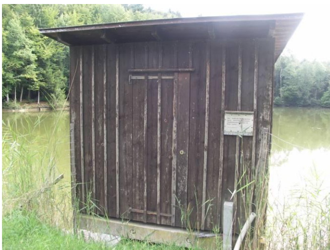
Fassungsbauwerk bei Burgerweiher
