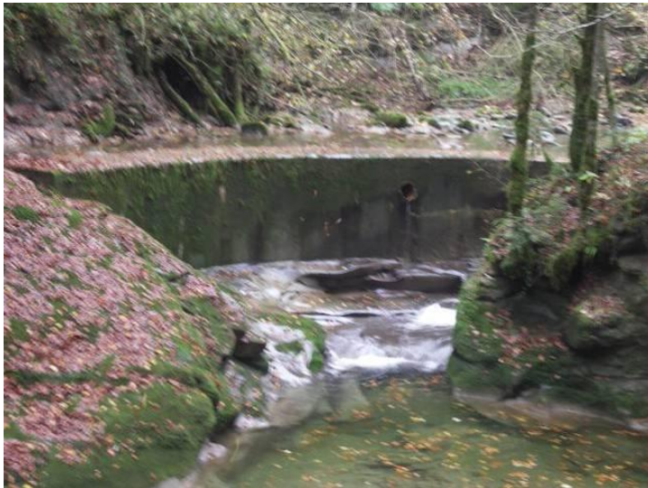
Fassung Ranzach unterhalb Lindenplatz, Sperre
