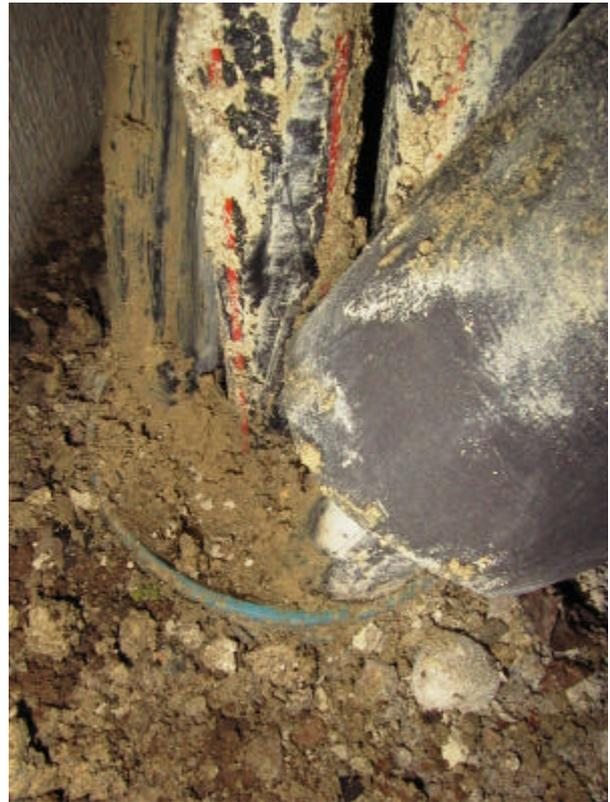
Schacht 60 cm zu 70 m EWS  $\varnothing$  32 mm. Nebst den 4 isolierten Erdwärmesondenrohren sind die Sensor-kabel, das Messrohr für den Fühler  $T_x$  und das Injektionsrohr sichtbar.
