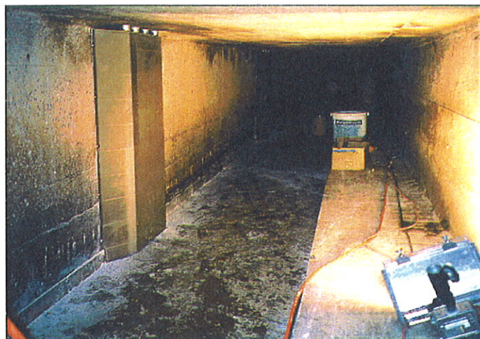
Das warme Abwasser fließt über die Wärmetauscherflächen. Links die Verschallung der Anschlussleitungen.
