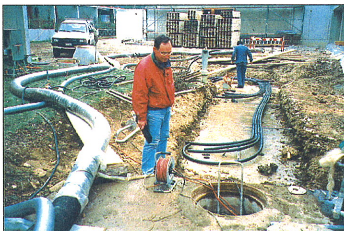
Das Abwasser musste während des Einbaus umgepumpt werden. Kurt Blatter überwacht das Ganze.
