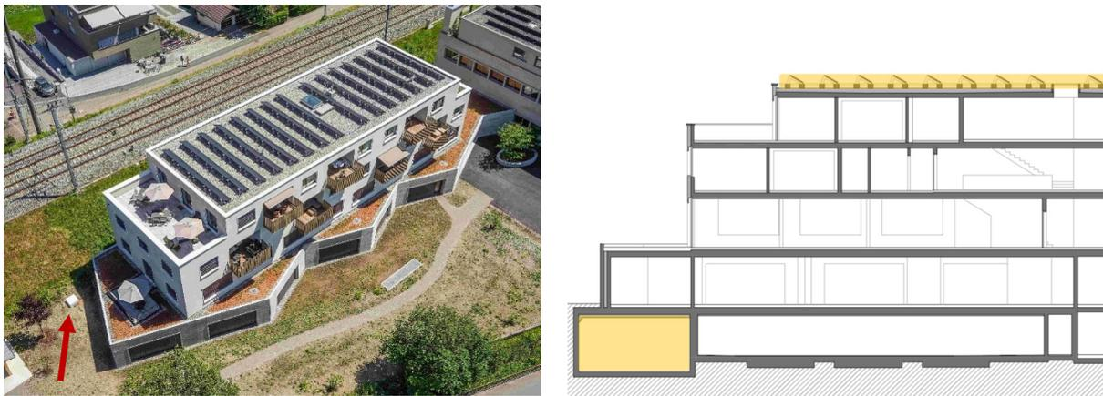
Abbildung 1: Luftbild des Gebäudes mit Kollektorfeld auf dem höchsten Dach und der Einstiegs Luke zum Eisspeicher (Pfeil links unten im Bild). Rechts: Ausschnitt aus Gebäudeschnitt mit farblich markiertem Kollektorfeld auf dem Dach und Eisspeicher im Erdreich neben der Tiefgarage.
