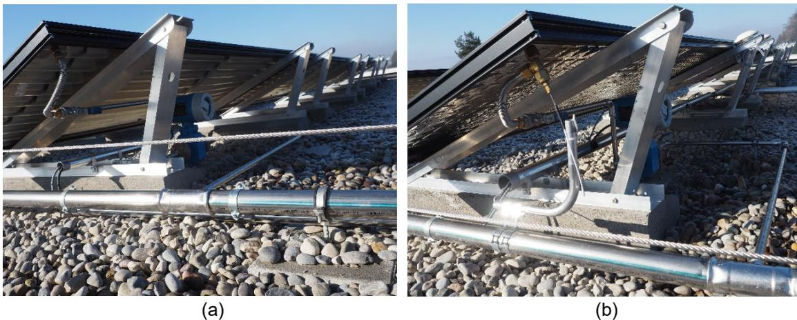
Abbildung 25: Ansicht (a) einer der rückseitig gedämmten Kollektorreihen und (b) der einzelnen Kollektorreihe, die rückseitig nicht wärmegeklämt ist.
