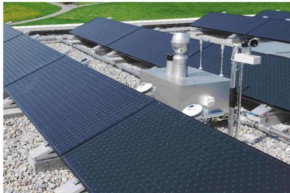
Abbildung 4: Kollektorfeld mit unverglasten, spektral selektiven Solarwärmekollektoren.
