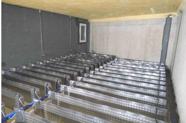
Abbildung 5: Blick in den Eisspeicher vor dem Befüllen mit Leitungswasser. Am Boden sind die enteisbaren Wärmetauscher montiert, welche eine Höhe von 62 cm haben. Im Hintergrund ist das Unterwasserfenster zur Tiefgarage sichtbar (weiss umrahmt).
