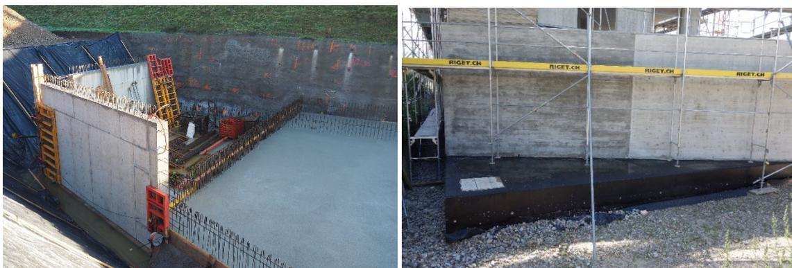
Abbildung 6: Links: Rohbau der Eisspeicherhülle (zwei Wände bereits errichtet) angrenzend an die Tiefgarage. Rechts: schwarz abgedichteter Teil der Eisspeicherdecke, der ausserhalb des Baukörpers liegt, vor dem Abdecken mit Erdreich.
