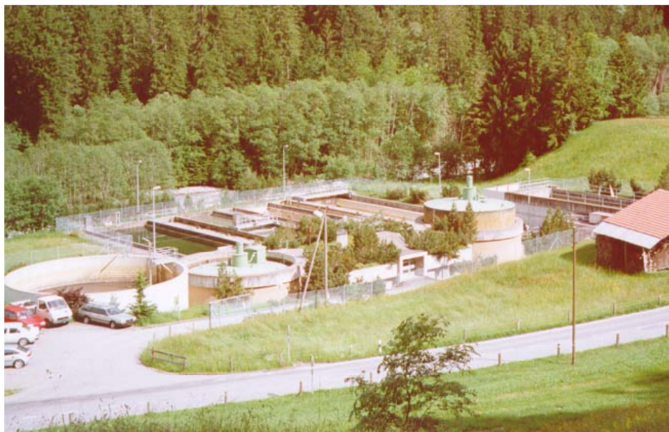
Photo 1 : STEP Neuweg Adelboden (gazomètre avec gaz de STEP)
