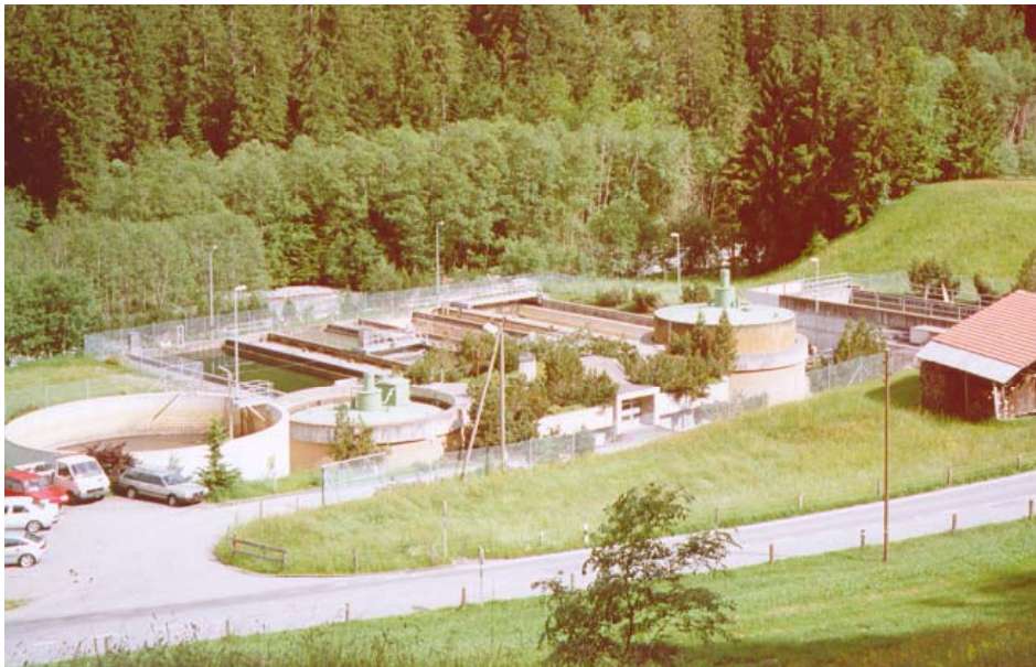
Bild 1: ARA Neuweg Adelboden („prallvoller“ Gasometer mit dem erneuerbaren Biogas) Quelle: Energetische Feinanalyse mit Schwerpunkt Co-Vergärung, Ryser Ingenieure AG
