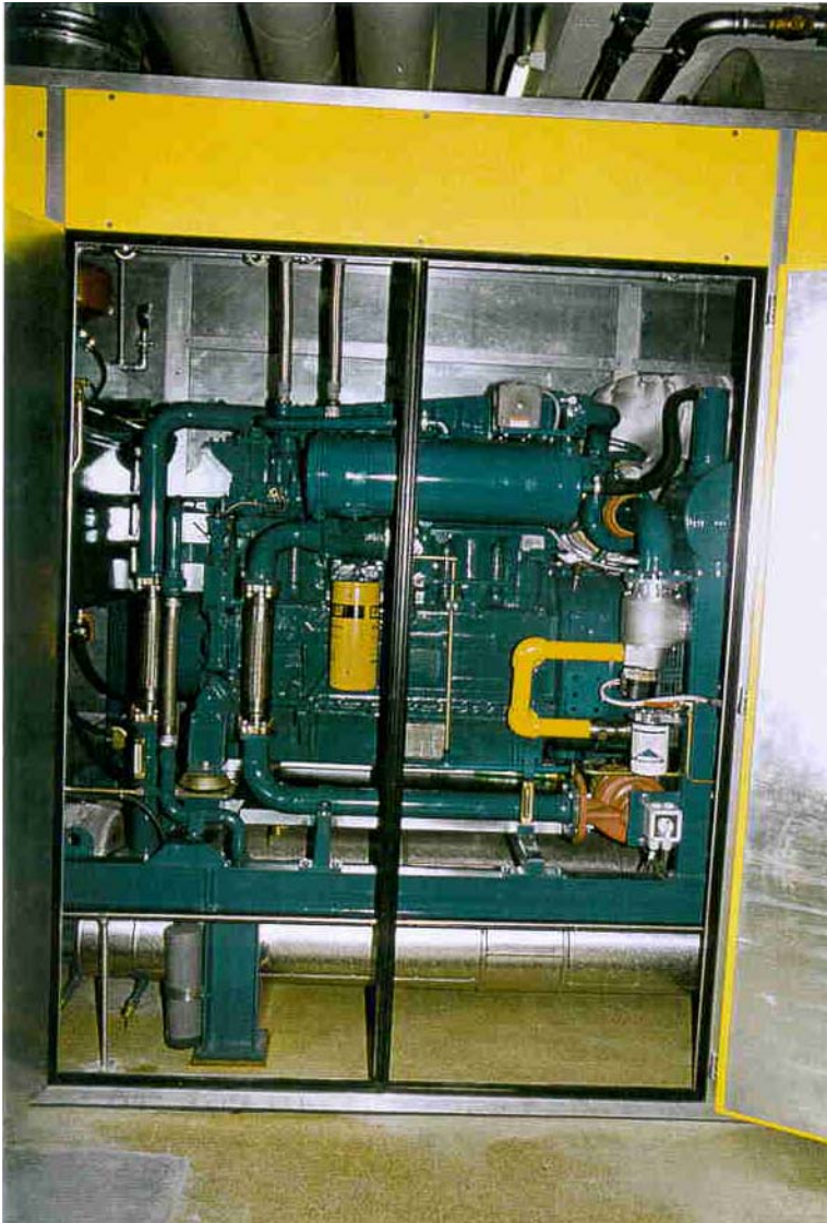
Bild2: ARA Herzogenbuchsee (Gasmotor)
