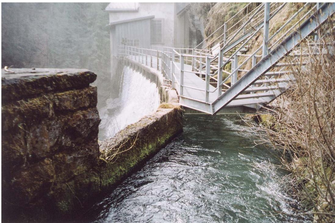
Bild 2: Oberwasserkanal mit nachfolgendem Entkieser, im Hintergrund ist das Rechenhaus erkennbar. Die Stahlkonstruktion gehört zum Thurweg.
