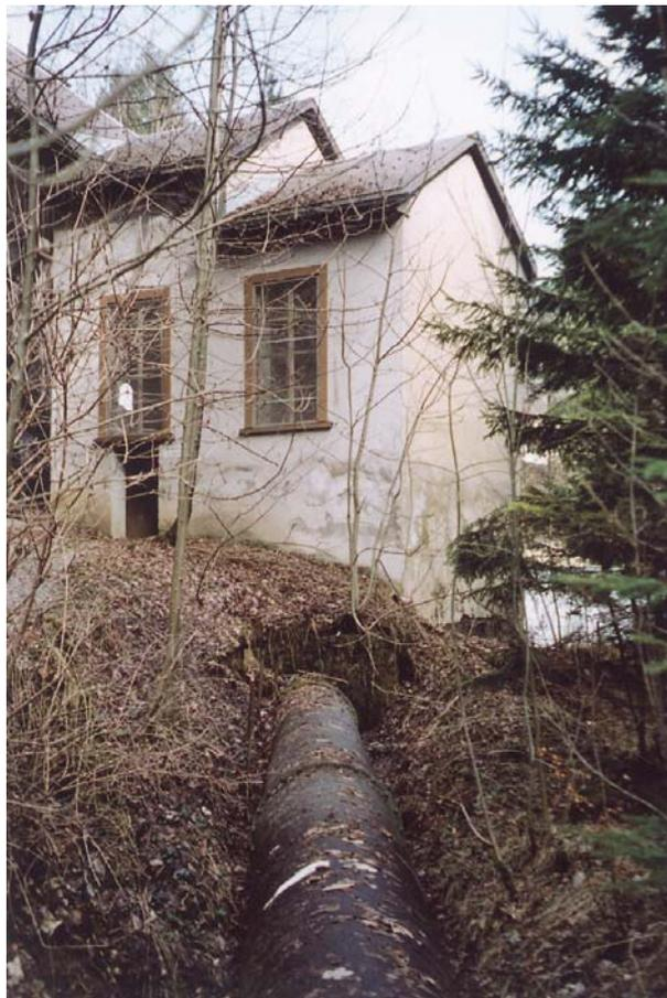
Bild 3: Rechenhaus mit Einlaufbauwerk in die Druckleitung: Im Vordergrund geht die Druckleitung mit DN 1000 in Richtung Zentrale weg.
