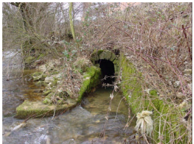
Abbildung 12: Mündung des Unterwasserstollens in die Ergolz. Zu erkennen ist das mit Bruchsteinen gemauerte Gewölbe.
