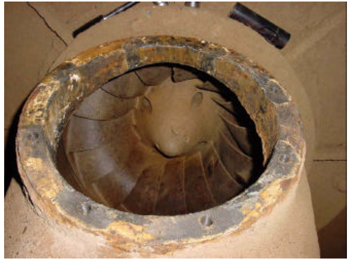
Abbildung 14: Francis-Schachtturbine
