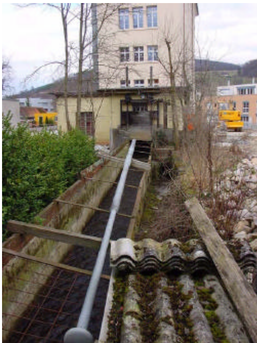
Abbildung 11: Kanalrinne kurz vor dem Eintritt ins Turbinenhaus. Im Hintergrund befindet sich das mehrstöckige ehemalige Mühle-Hauptgebäude.
