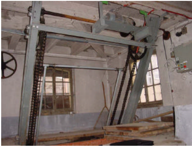
Abbildung 13: Rechenanlage im Turbinenhaus
