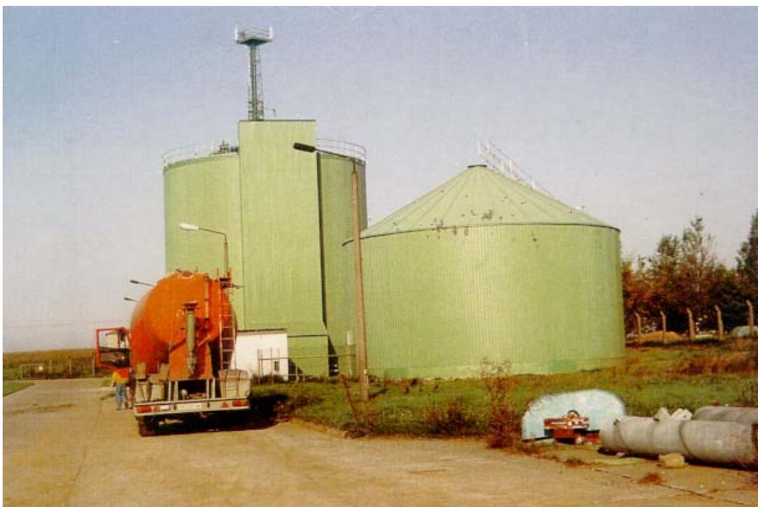
Fig. 8 *Biogasanlage Grossvoigtsberg/Sachsen – Fermentervolumen 2'500 m<sup>3</sup> – Substratinput ca. 40'000 m<sup>3</sup> / a; [ 4 ]*
