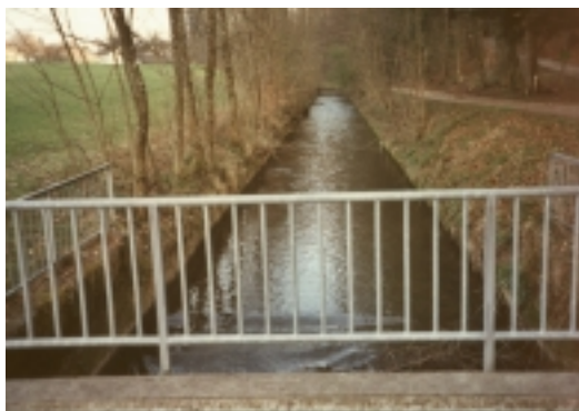
Ansicht vom Projektstandort Flussaufwärts
