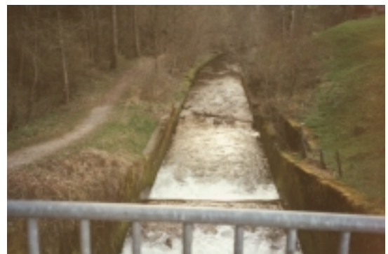
Ansicht vom Projektstandort Flussabwärts
