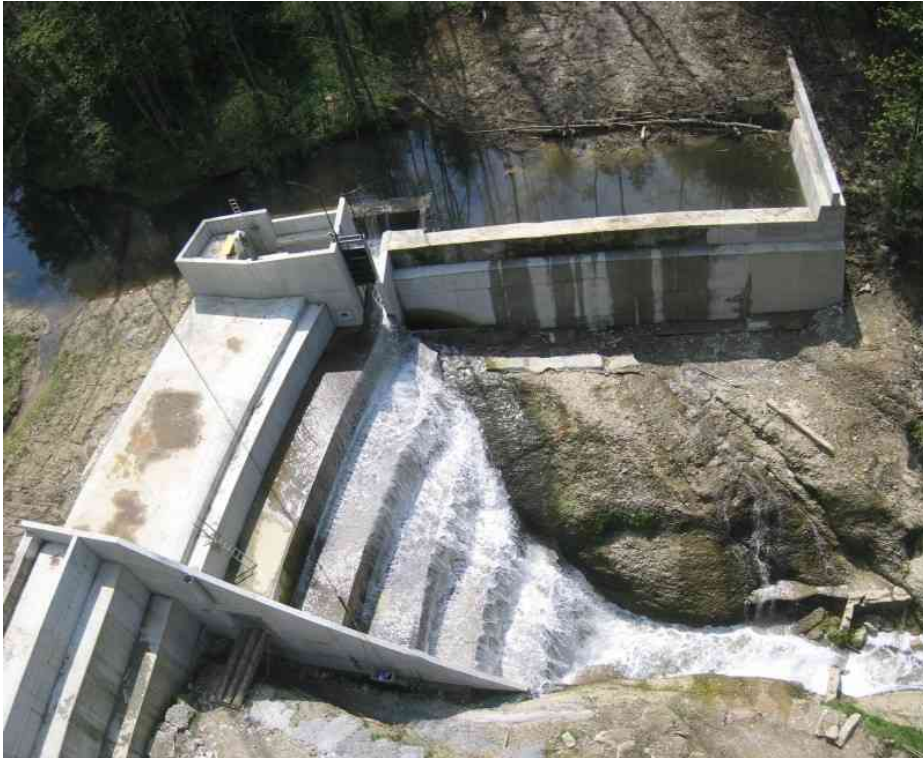
Bild 21: Stauanlage nach Fertigstellung der Bauarbeiten (11.05.06)
