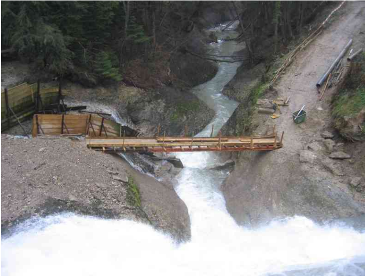
Bild 19: Blick ins Unterwasser bei Überströmung Wehrfeld (10.04.06)
