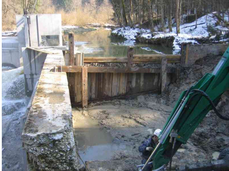
Bild 10: Sanierung Streichwehr (07.04.06)
