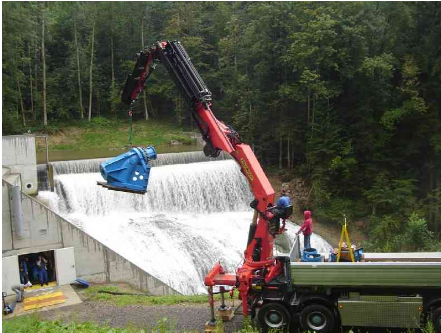
Bild 14: Einbau Turbine (29.08.06)
