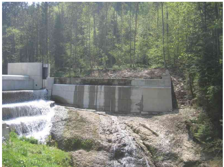
Bild 13: Abschluss Sanierung Streichwehr (11.05.06)
