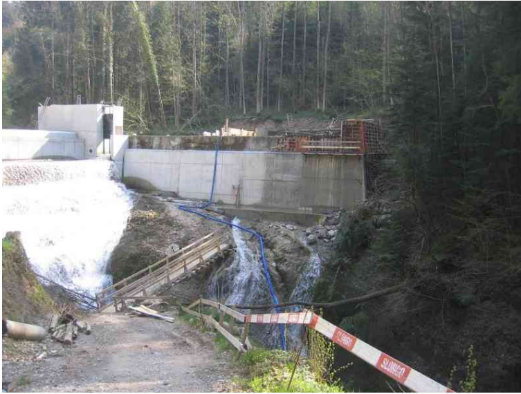
Bild 12: Sanierung Streichwehr (02.05.06)
