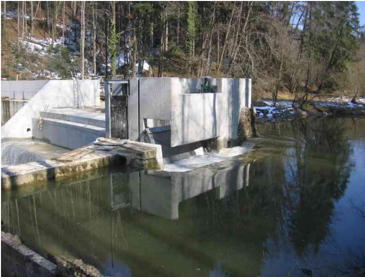
Bild 4: Eingebaute Rechenreinigungsanlage (07.04.06)
