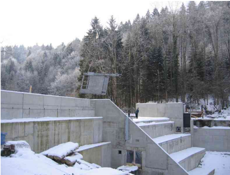
Bild 1: Einbau Rechen (12.01.06)
