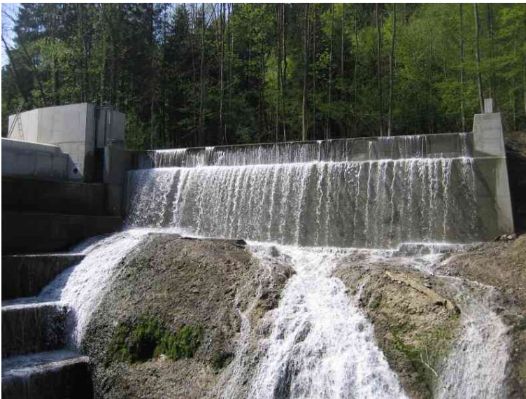
Bild 20: Überströmtes Streichwehr (12.05.06)
