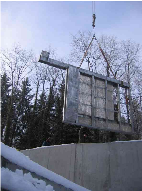
Bild 2: Einbau Rechen (12.01.06)
