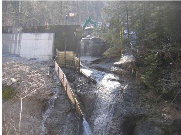
Bild 9: Sanierung Streichwehr (07.04.06)
