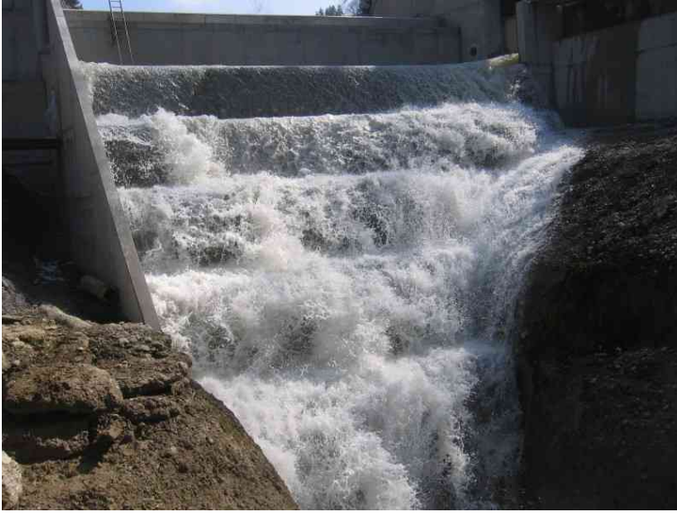
Bild 8: Überströmte Staumauer bei geöffnetem Grundablass (07.04.06)
