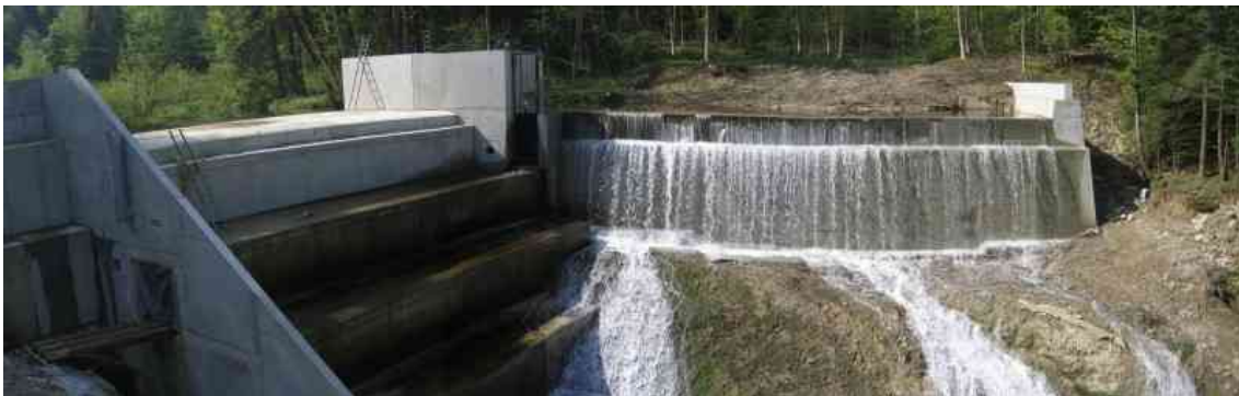
Bild 22: Stauanlage nach Fertigstellung der Bauarbeiten (11.05.06)
