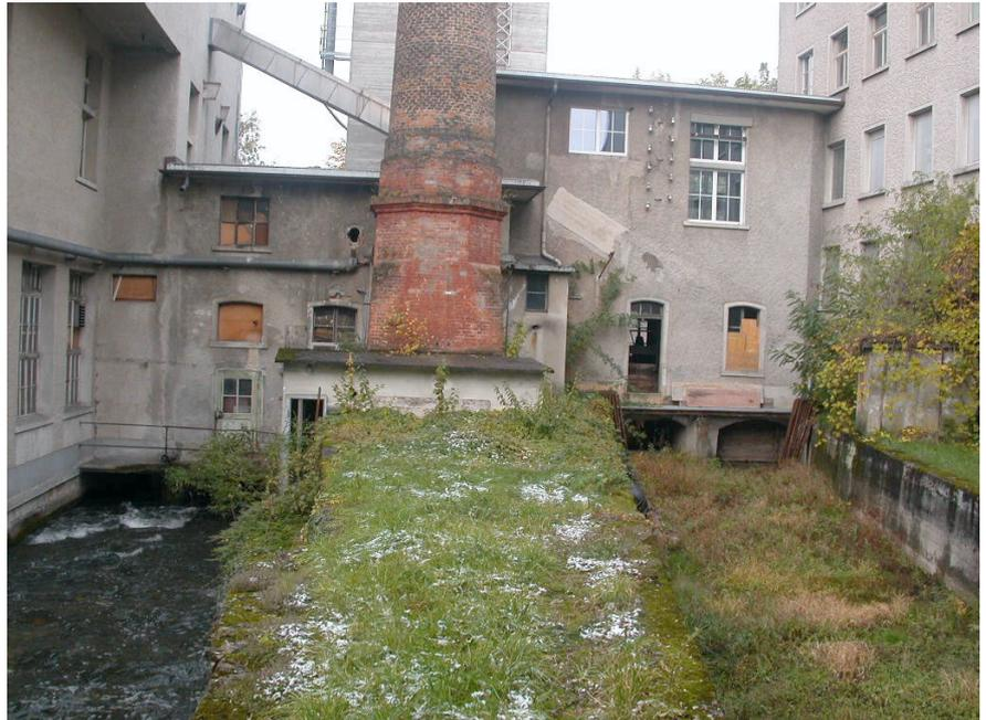
Vorderansicht des Kraftwerksgebäudes (Industriebrache) mit den beiden Einläufen zu den Zwillings-Turbinen. Der Feinrechen wurde demontiert
