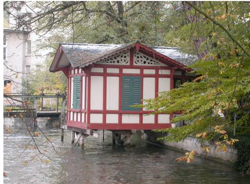
Die Stützen für das Badehaus sind dem stark schwankenden Wasserspiegel des Aabaches ausgesetzt und in einem desolaten Zustand. Das Holz ist morsch und die Stützen sollten dringend erneuert werden.
