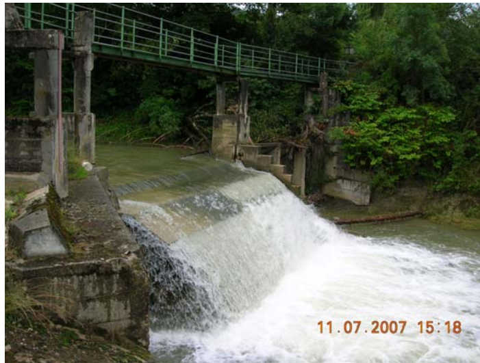
Photo 1. Barrage – passage de l'eau sur le seuil primaire
