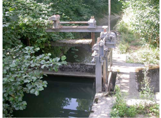
Einlaufschütz Oberwasserkanal
