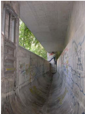
Hochwasserentlastung in der Restwasserstrecke Hetex, Niederlenz.
