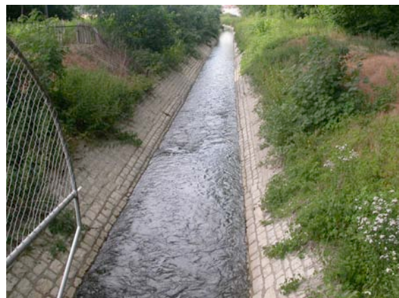
Oberwasserkanal in Trapezform (bei Niedrigwasser)
