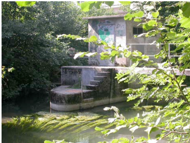
Stauwehr mit Trennpfeiler und Steuerhaus
