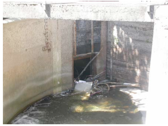
Grundablass neben geschlossenem Haupteinlaufschütz, dahinter Feinrechen.
