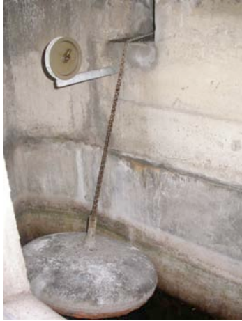
Schwimmer zur Regelung Klappwehr
