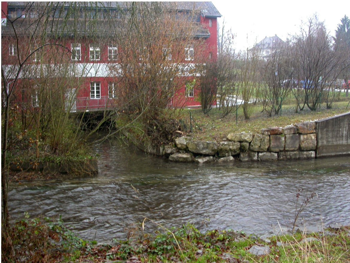
Abb. 10: Tommasini-Gebäude mit Unterwasserkanal
