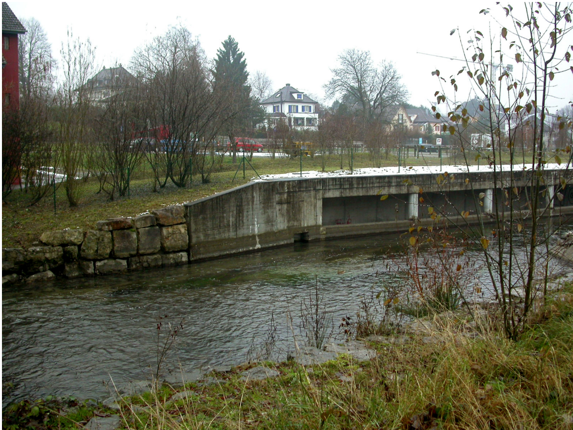
Abb. 17: Einlaufbauwerk Hochwasserentlastung Lenzburg
