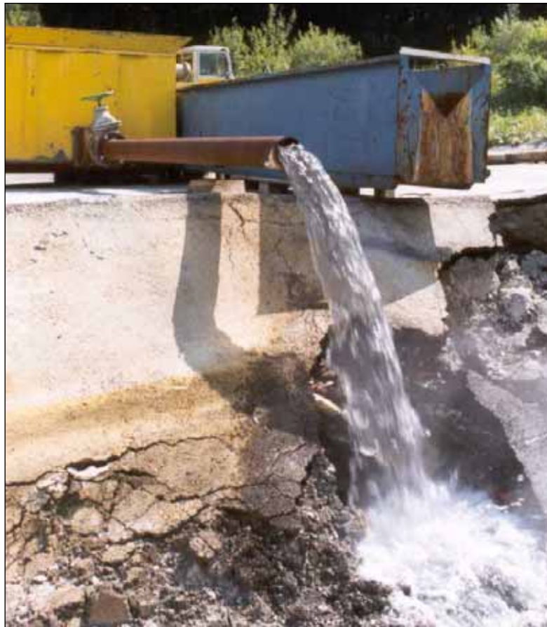
Test de production du puits P600 à Lavey-les-Bains
