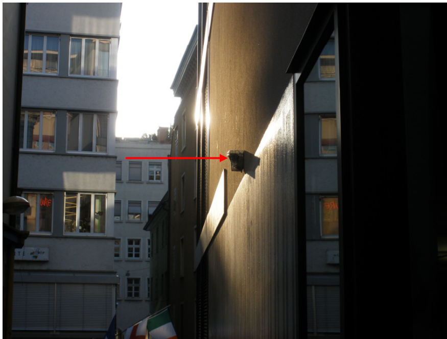
Abb. 7: Temperaturfühler mit Beschattung
