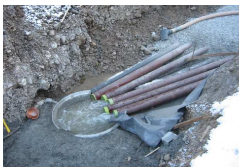
Figure 3 : Construction du captage de Clarive
