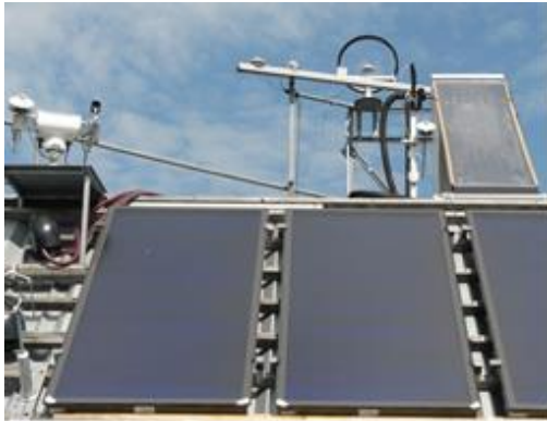
Abb. 9: Foto der thermischen Solarkollektoren auf dem Labordach (links). Skizze zu den Kollektoren mit Mäander-Absorbern aus Aluminium (rechts). Der Wärmeträger-Fluid Eintritt in das Kollektorfeld ist unten links und der Austritt oben rechts. Das Material der Rohrleitungen für Vorlauf und Rücklauf zum Speicher besteht aus Kupfer. Mit dem aus Baustahl gefertigten Wärmeübertrager im Speicher entsteht eine (Material-) Mischinstallation in welcher das Aluminium der Absorberrohre zur Opferanode wird. Zudem kann das Kollektorfeld bei Stagnation nicht entleeren.
