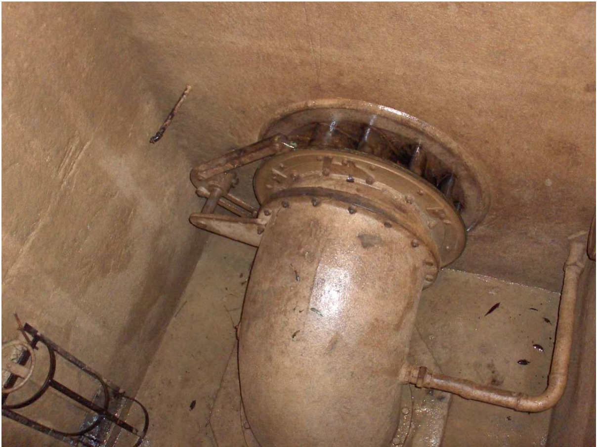
Abbildung 2.: Entwässerter Turbinenschacht des KW Albisser mit Francis-Schachtturbine; sichtbar sind Wassereinlauf mit Leitapparat und Saugrohrbogen.
