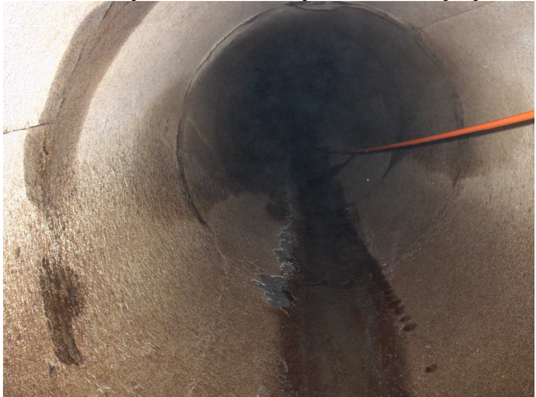
Abbildung 4: Zustand der bestehenden Druckleitung aus Beton. Die Wandrauhigkeiten sind relativ gering, mit Ausnahme der Fugenbereiche. Erkennbar sind auch die abgeplatzten Kalkablagerungen im Sohlenbereich. Die feuchten Stellen bei den Quertugen links im Bild lassen auf Wasserverluste in diesen Bereichen schließen.
