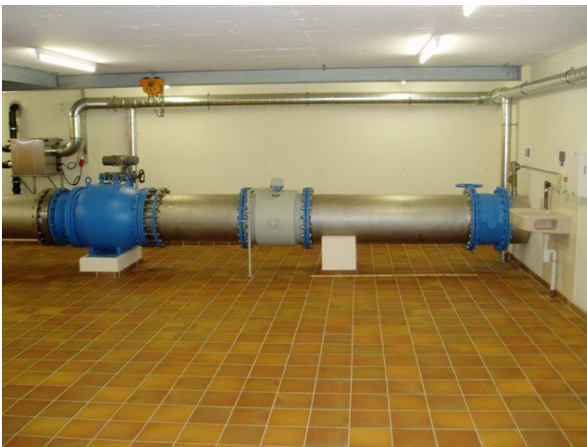
Bild 3: Zubringerleitung Tösstal mit Absperrklappe, Durchflussmessung (MID) und Ringkolbenschieber
