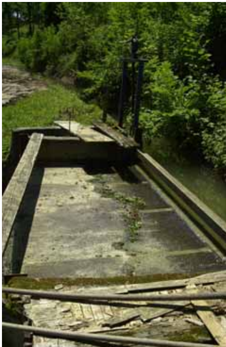
Photo 3. Canal d'amenée, dégrilleur et départ de la conduite en écoulement libre
