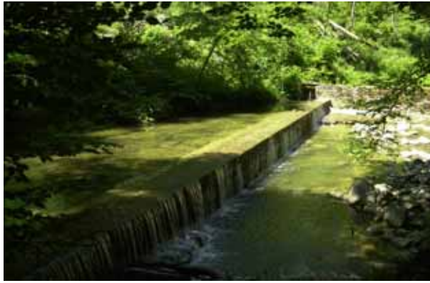
Photo 1. Seuil et prise d'eau sur le Talent
