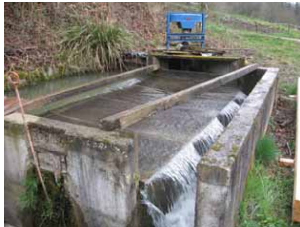
Photo 6. Prise d'eau actuelle, équipée d'une grille horizontale
