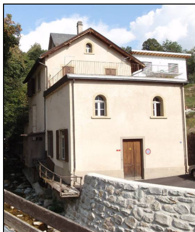
Abb. 19 bestehende Zentrale Kelchbach
