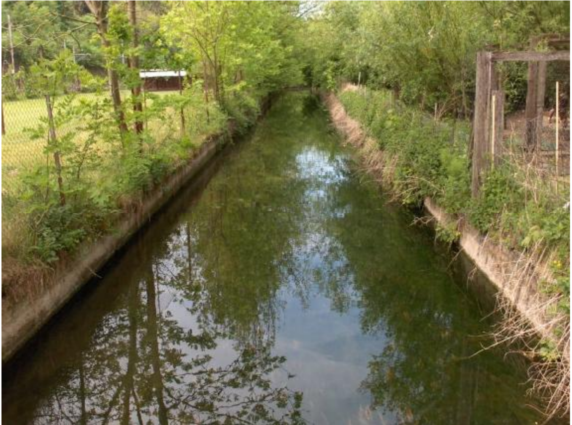
Bild 3: Oberwasserkanal mit beidseitiger Betonauskleidung.
