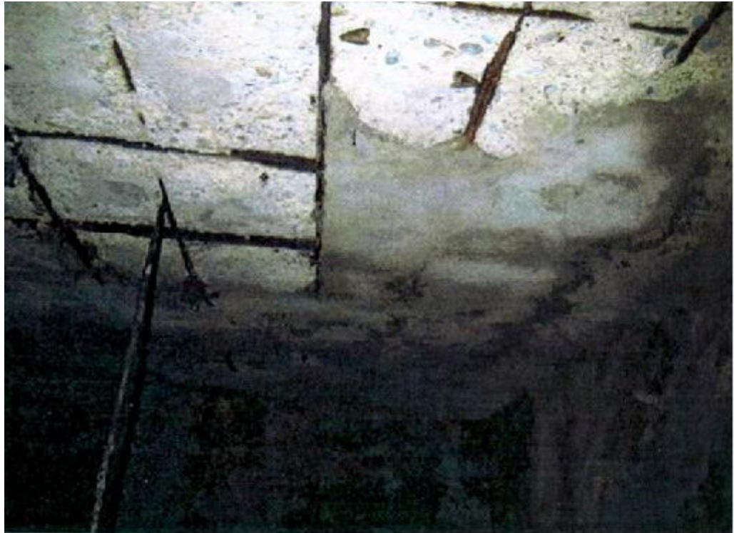
Bild 10: Betondecke über dem UW-Kanal mit grossflächigen Abplatzungen, verursacht durch die korrodierte Armierung (Quelle: Ref. [11]).
