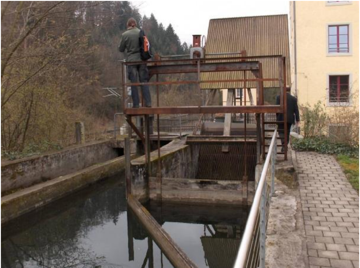
Bild 6: Oberwasserbecken mit Geschwemmselabweiser (Schwimmbalken), Einlaufschütze, Rechen mit Rechenreiniger und Entlastungswehr links im Bild.
