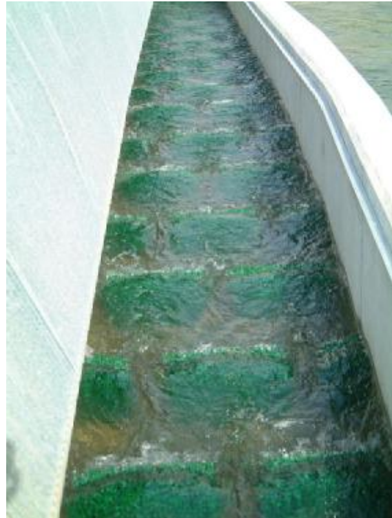
Bild 17: Beispiel eines Borstenfischpasses (Quelle: Hydrosolar)
