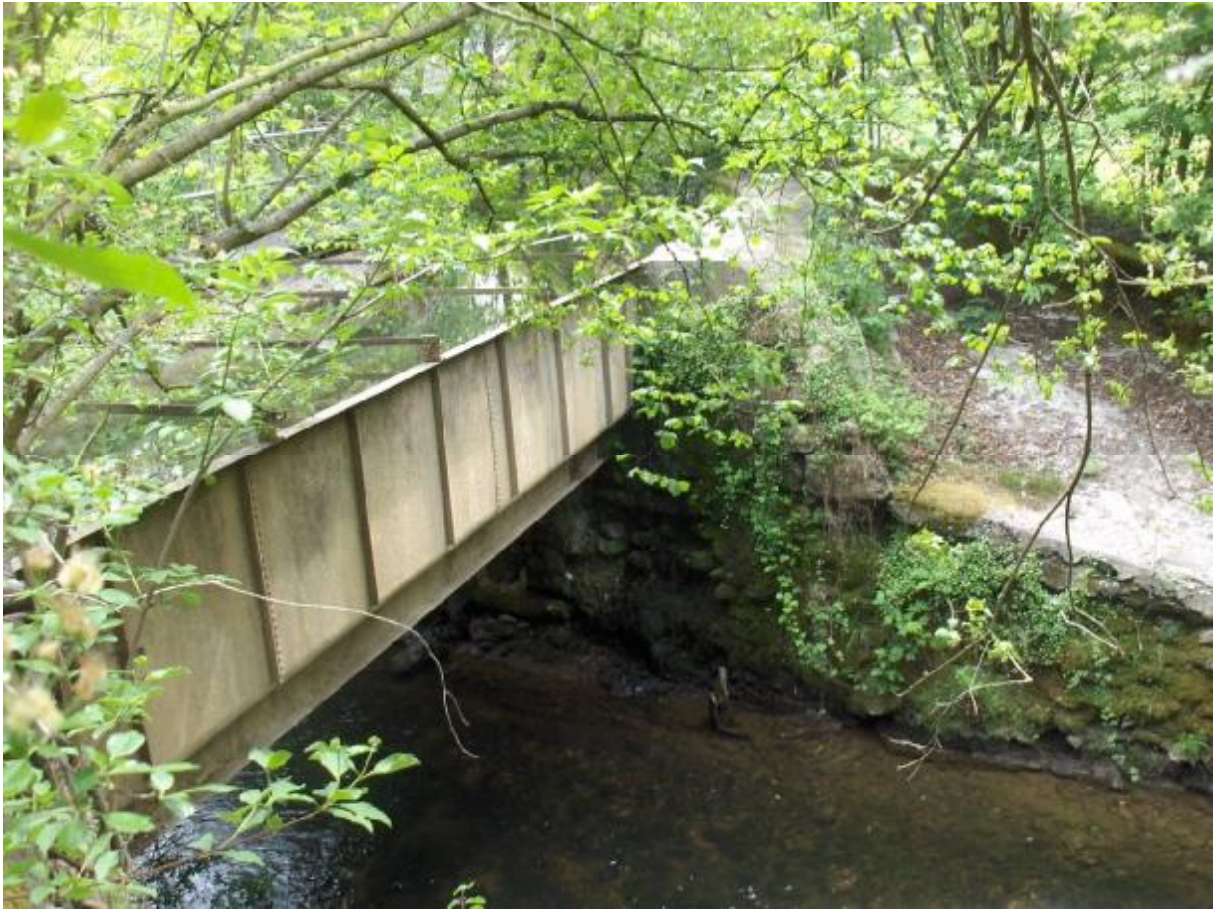
Bild 5: Trogbrücke über den Aabach mit Widerlagern, die saniert werden müssen.
