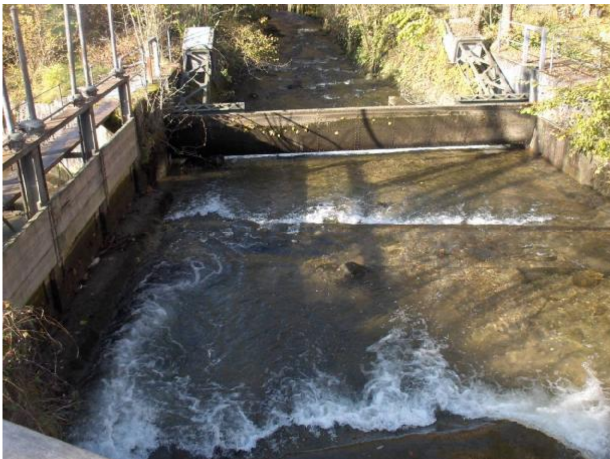
Bild 2: Wasserfassung mit Einlaufschützen links und der Segmentschütze mit Gegengewicht im ungestauten Zustand.
