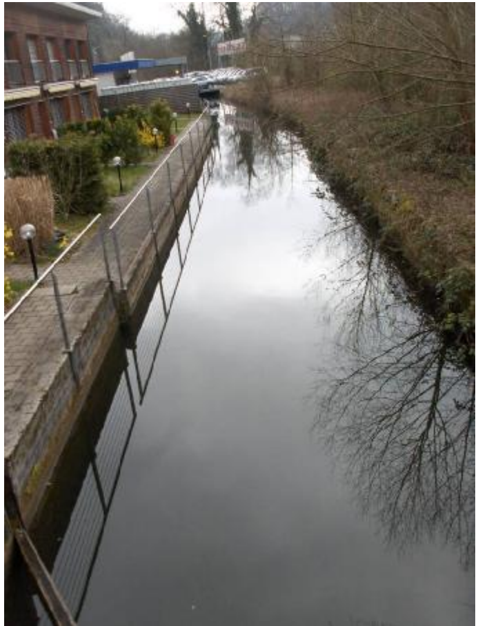
Bild 7: Oberwasserkanal mit neu angelegten tiefliegenden Gärten links im Bild. Die Dichtigkeit der Kanalwand, insbesondere für den Notschlussfall der Turbinen und dem anschliessenden Schwall, ist zu überprüfen.
