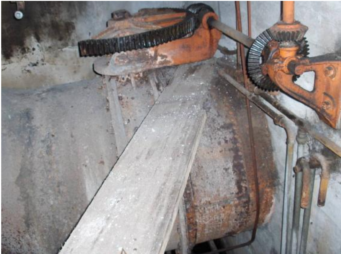
Bild 9: Druckleitung zur grösseren Turbine mit Absperrklappe vom Turbinenraum aus gesehen.
