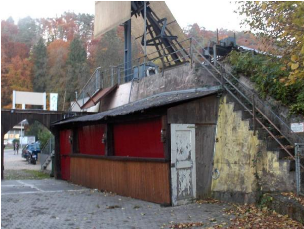
Bild 21: Am Ort dieser ehemaligen Bar am Oberwasserbecken soll der Treppenabgang zum unterirdischen Maschinenhaus in ähnlichen Abmessungen aber aus Beton (gegen Lärmimmissionen) entstehen.
