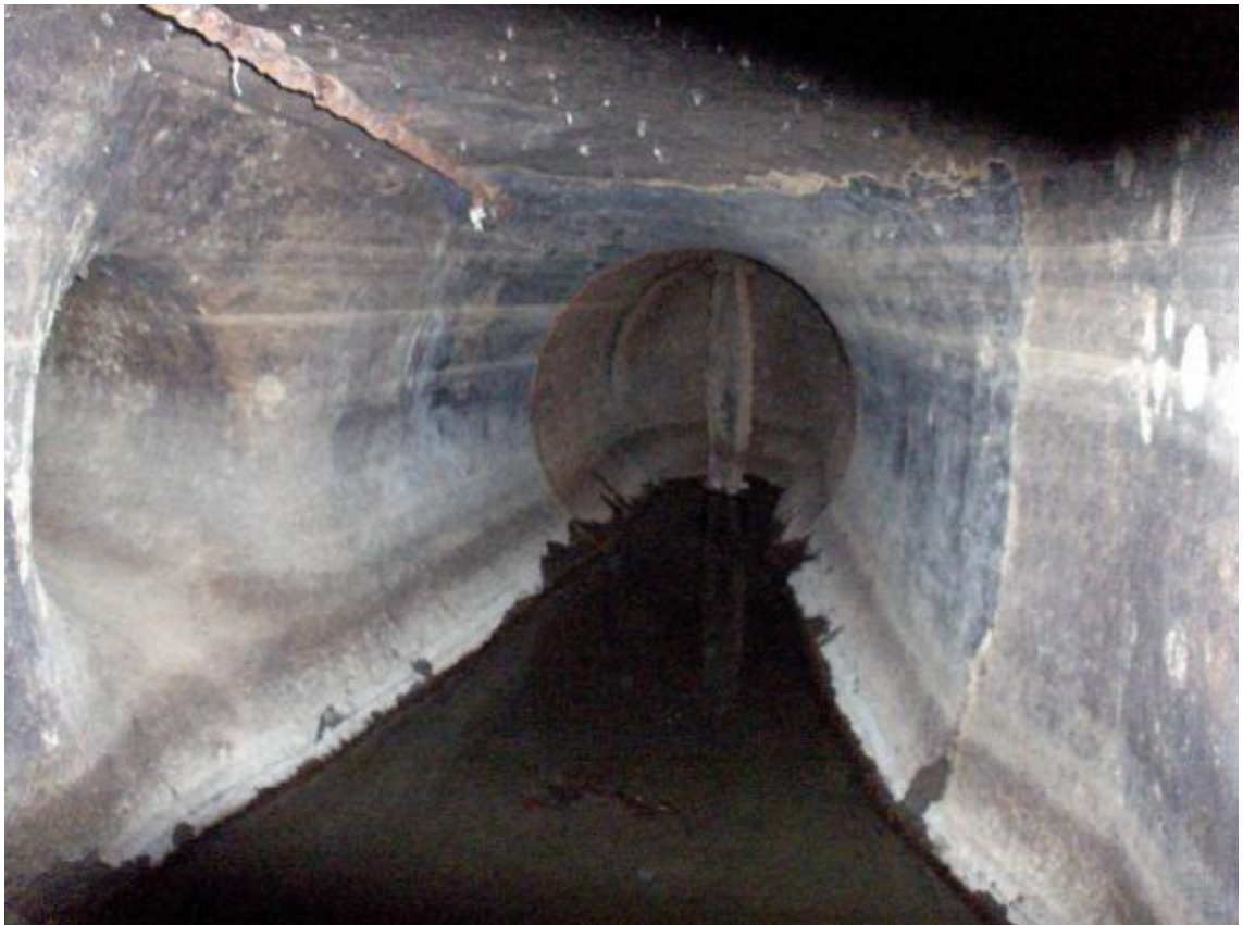
Bild 8: Druckkanal im Übergang zu den Druckleitungen mit der alten Abschlussklappe der grossen Turbine und dem Abgang zur kleinen Turbine links im Bild..
