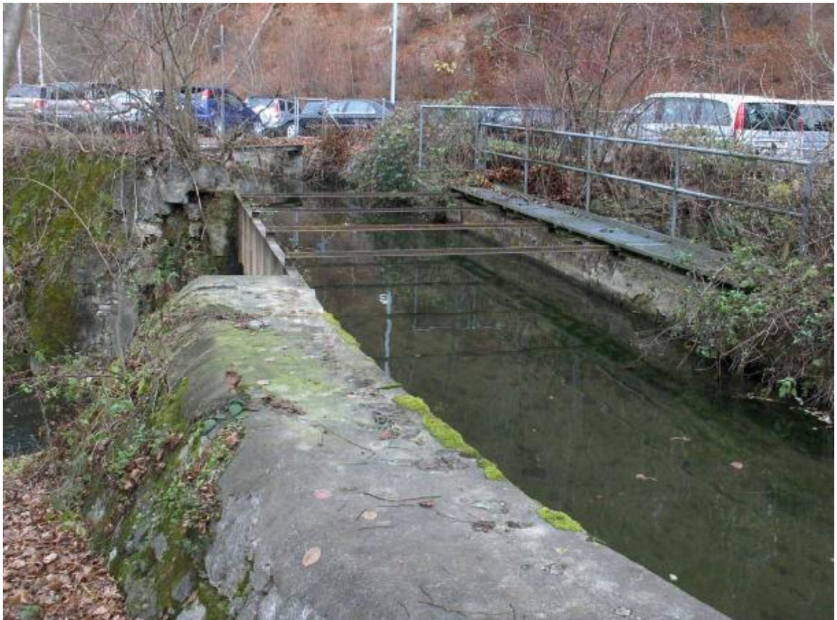
Bild 4: Trogbrücke über den Aabach mit der seitlichen Entlastung im Vordergrund.
