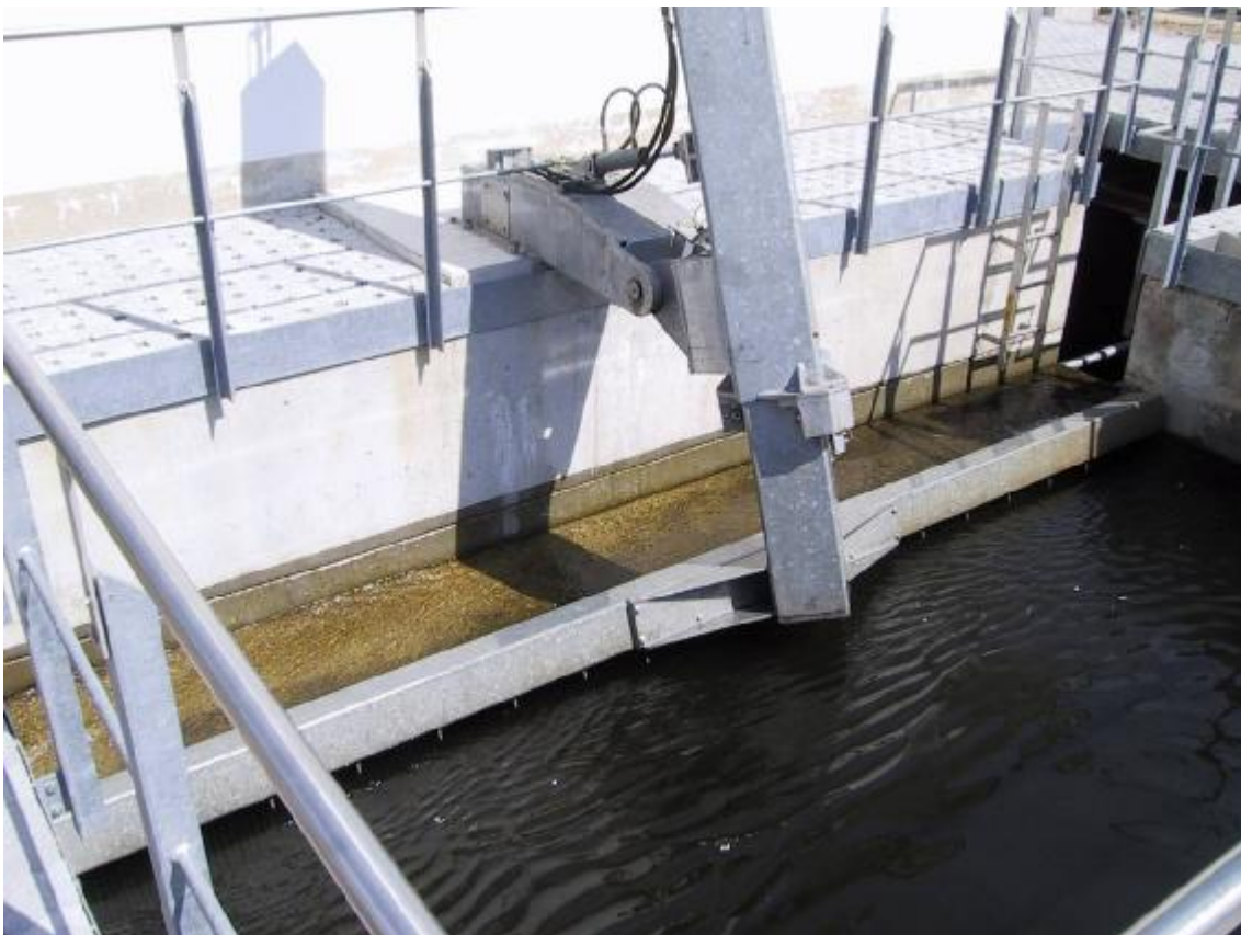
Bild 19: Rechenreinigungsanlage mit eingetauchter Spülrinne, die die Rückgabe des Geschwemmsels an das Gewässer ermöglicht.
