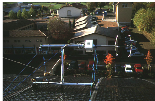
Anémomètre ultrasonique 3D placé à 50 cm de la toiture solaire (bâtiment 6-7).
